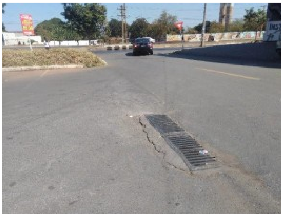
Figura 4 - Boca de Lobo Dupla com Grelha
