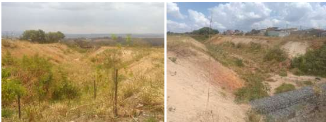
Figura 40 - Erosões em Ceilândia (Condomínio Privê) - situação atual.
