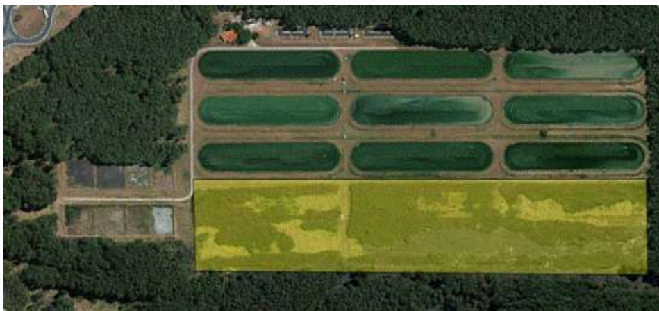
Figura 13 - Área disponível para ampliação da ETE Paranoá.
