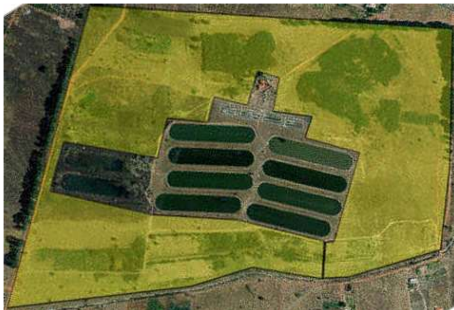
Figura 16 - Área disponível para ampliação da ETE Santa Maria.
