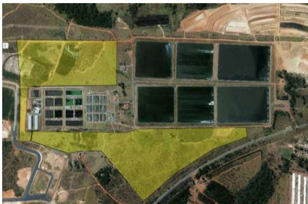
Figura 12 - Área disponível para ampliação da ETE Samambaia e ETE Melchior. Fonte: SEGETH/DF, 2017.
