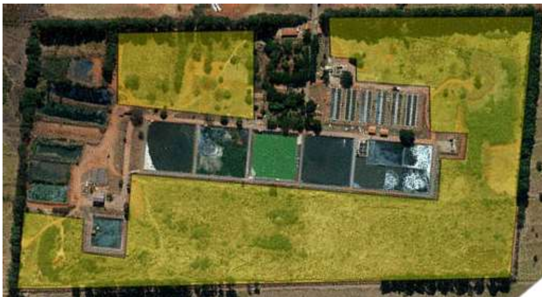
Figura 15 - Área disponível para ampliação da ETE Recanto das Emas.
