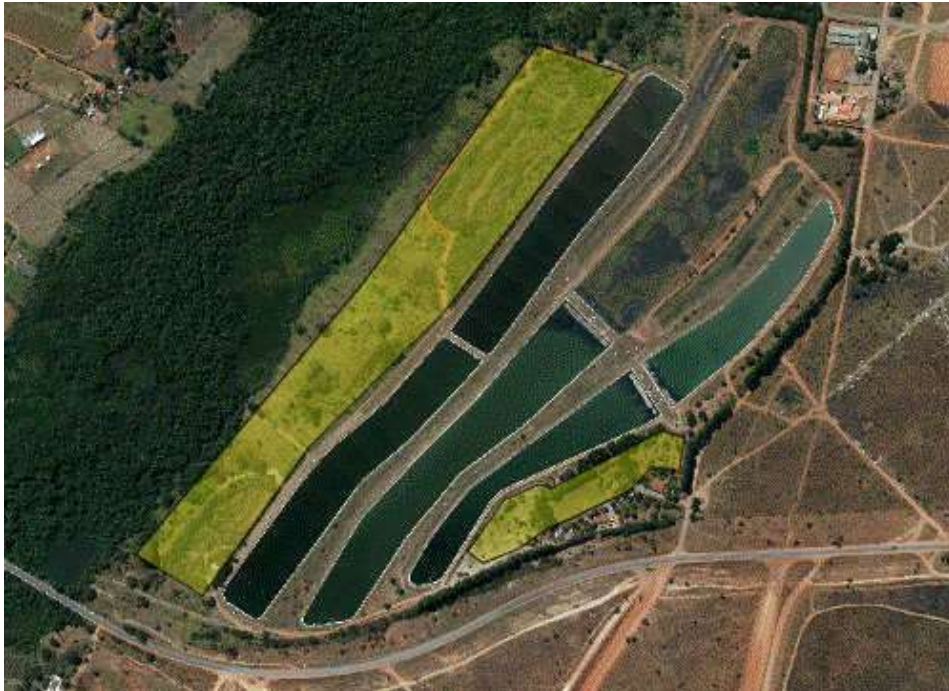
Figura 14 - Área disponível para ampliação da ETE Planaltina.
