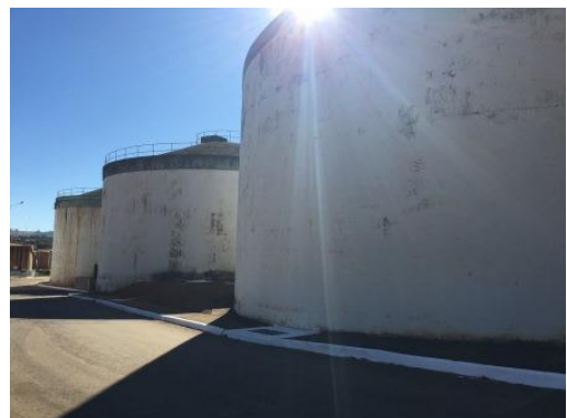
Digestores por gravidade
