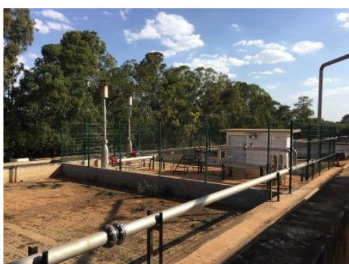
Queimador de gás dos digestores
