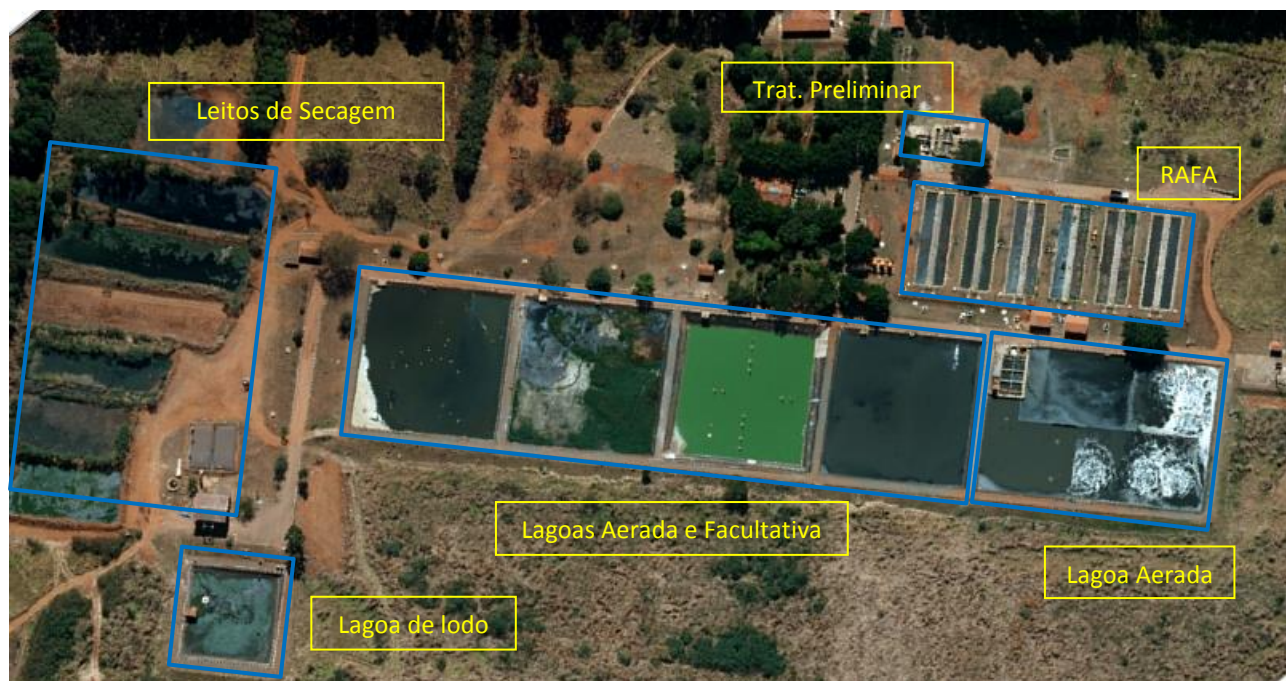
Figura 204 - Área da ETE Recanto das Emas.
