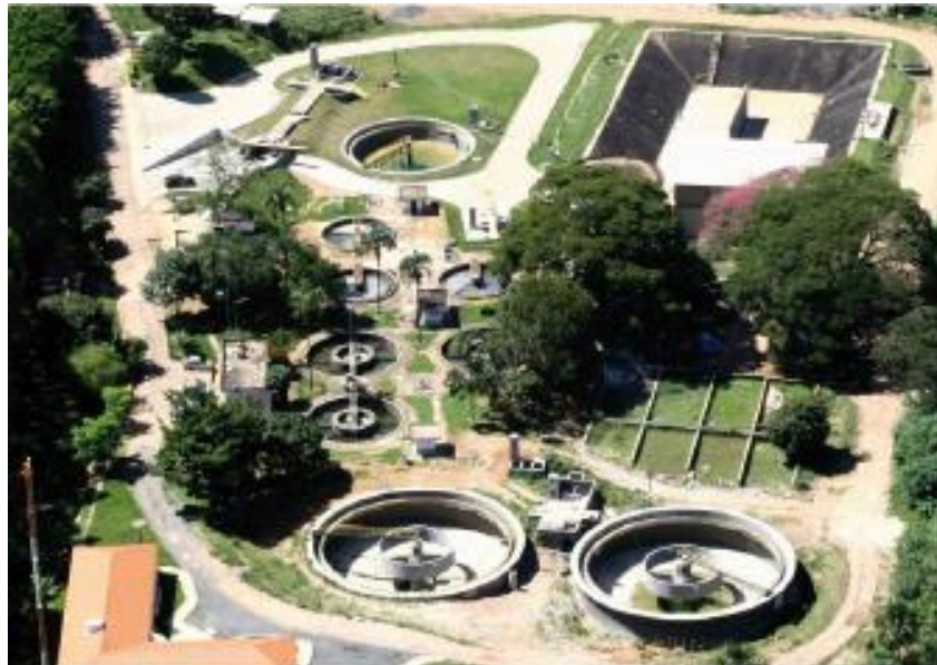
Figura 117 - Vista aérea da ETE Sobradinho. Fonte: SIESG, 2014.
