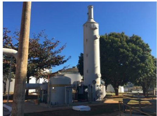
Lavador de gás
