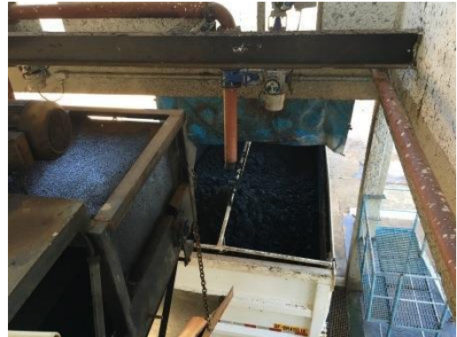
Caminhão para transporte de lodo
