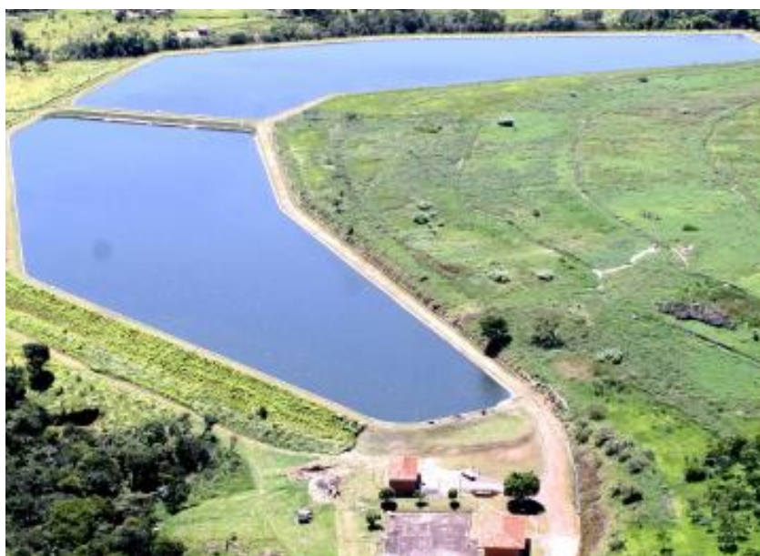
Figura 195 - Vista aérea da ETE São Sebastião.
