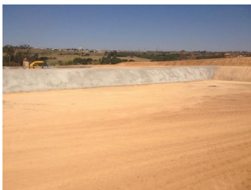
Bacia com talude protegido com concreto
