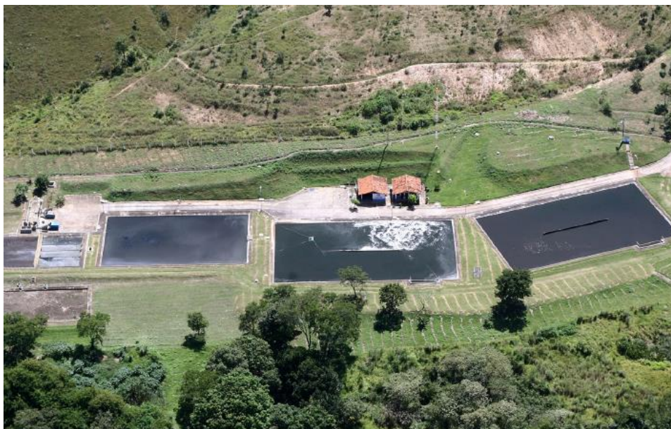
Figura 139 - Vista aérea da ETE Vale do Amanhecer.
