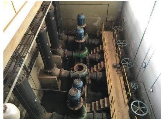
Bombeamento da elevatória para o início do tratamento
