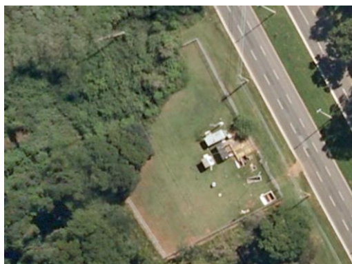
Vista aérea da elevatória
