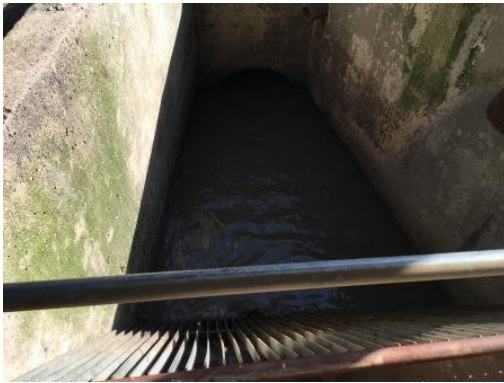
Chegada de esgoto bruto na elevatória localizada dentro da ETE
