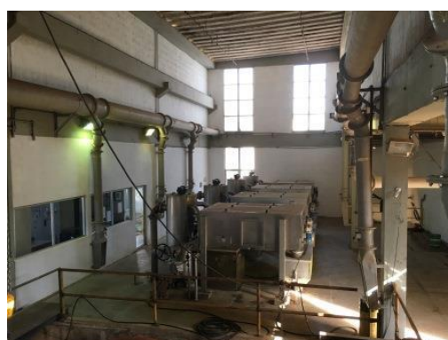
Adensador mecânico
