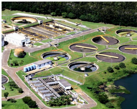
Vista aérea de parte da ETE
