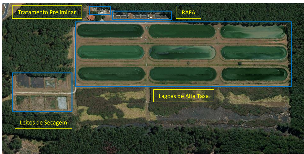
Figura 150 - Área da ETE Paranoá. Fonte: Adaptado CODEPLAN/DF, 2016.
