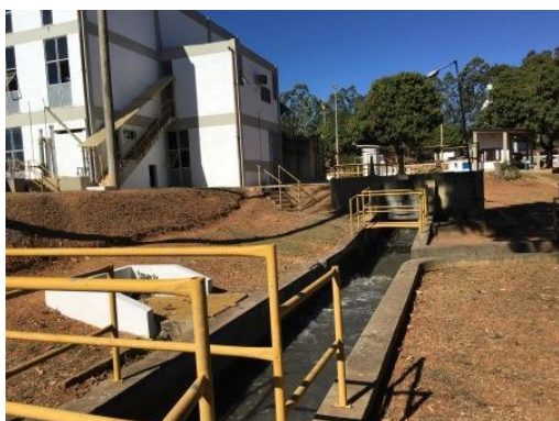
Canal de chegada no Tanque de Equalização
