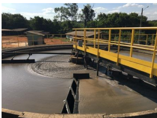
Adensador lodo do decantador primário
