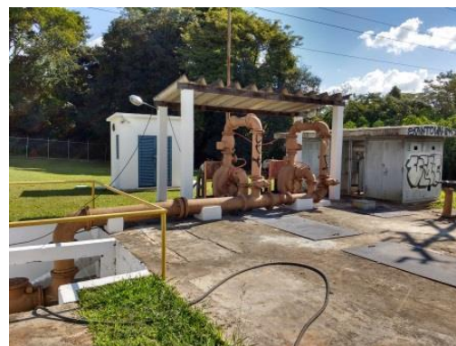
Poço de sucção, bombas e barrilete
