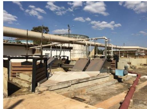
Gradeamento fino no tratamento preliminar
