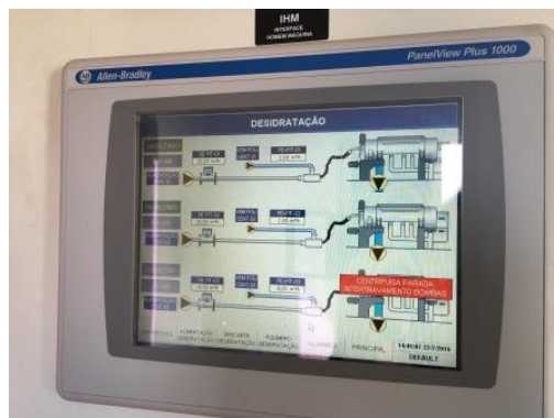
Supervisório de controle do sistema
