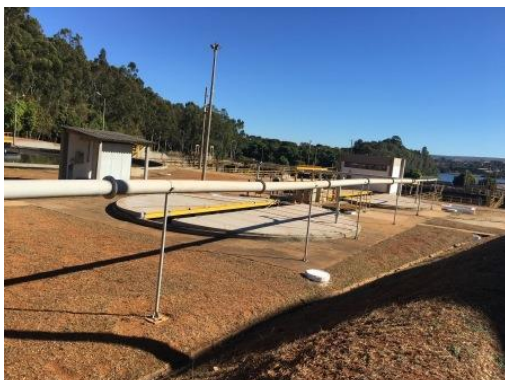
Adensador de lodo por gravidade
