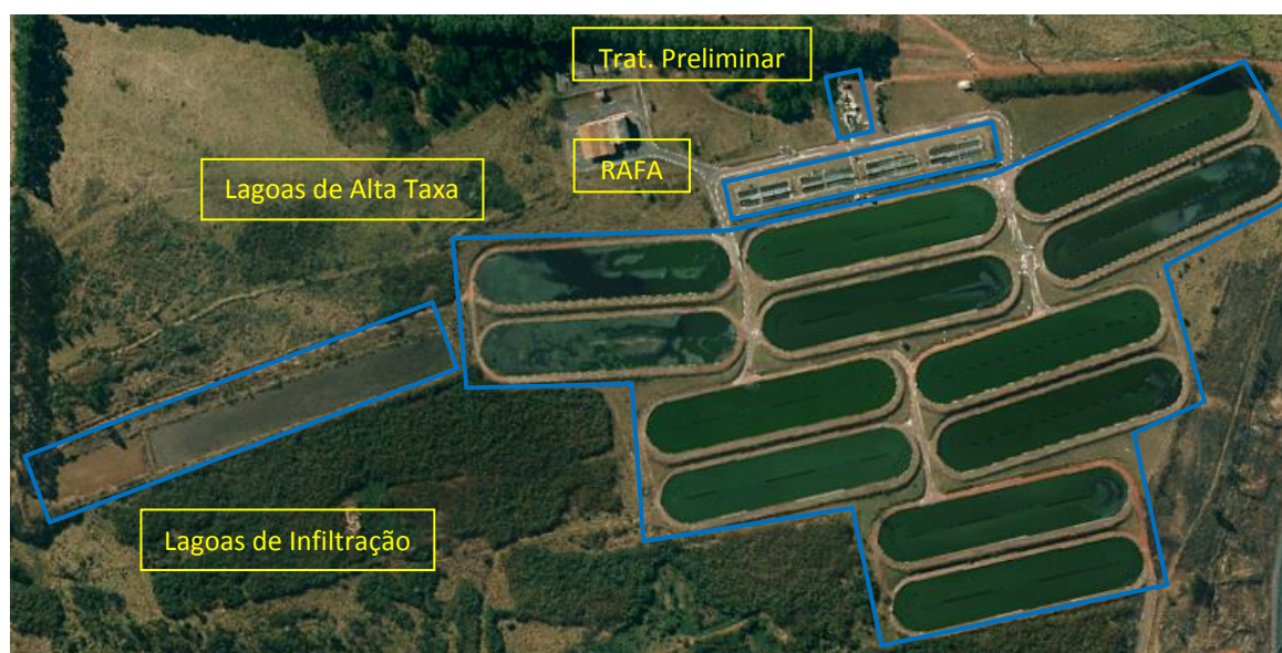
Figura 182 - Área da ETE Alagado.
