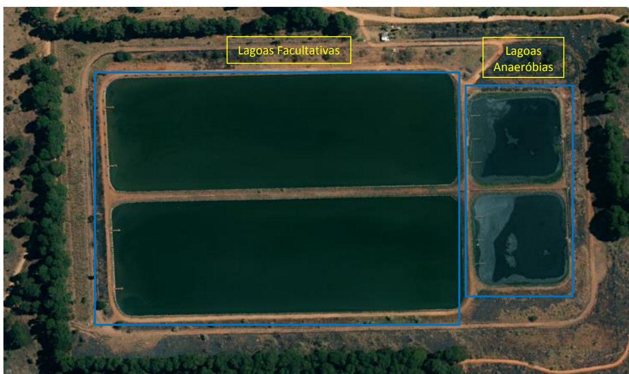
Figura 106 - Área da ETE Brazlândia. Fonte: Adaptado CODEPLAN/DF, 2016.
