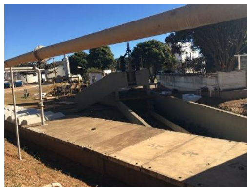
Canal coberto para o Tratamento Preliminar e canal descoberto para o Tanque de Equalização
