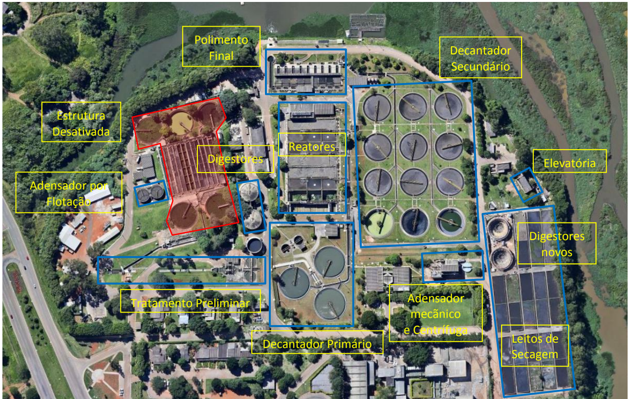
Figura 69 - Área da ETE Brasília Sul.
