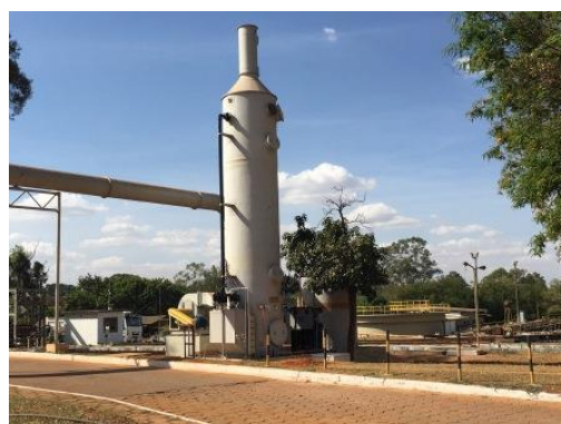
Lavador de gás
