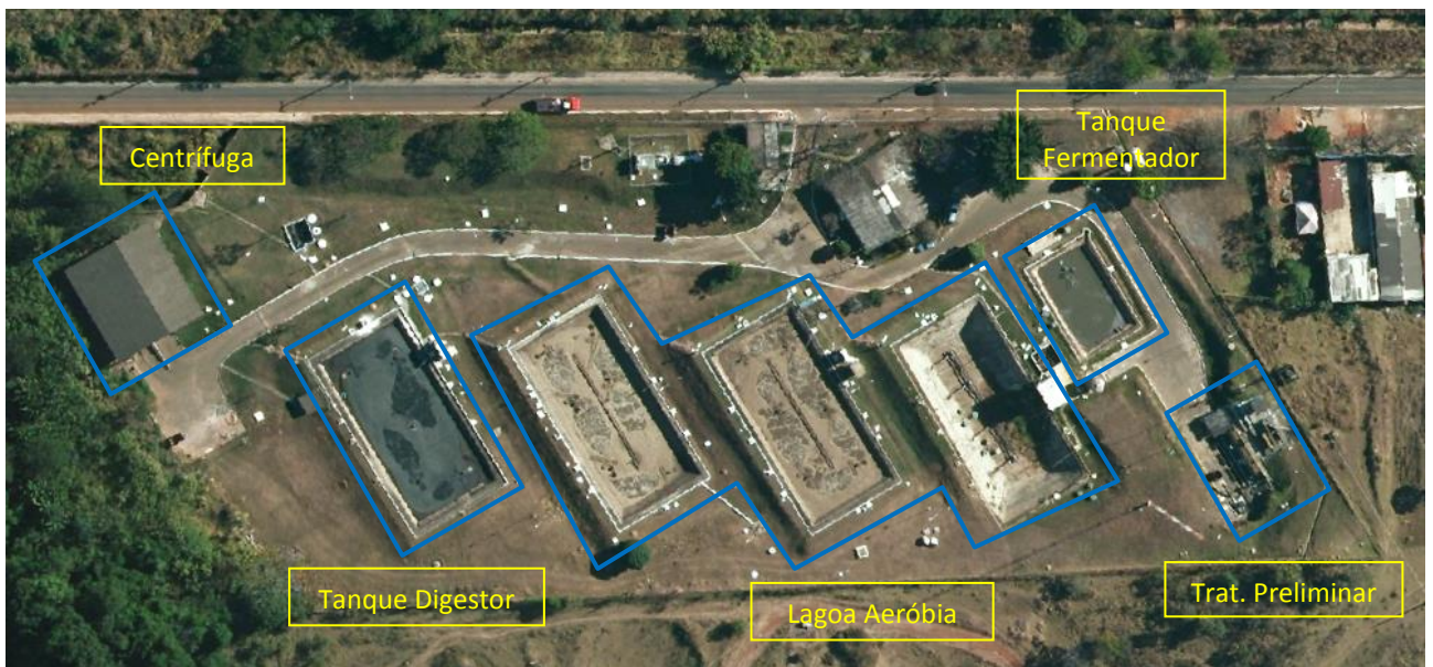
Figura 214 - Área da ETE Riacho Fundo.
