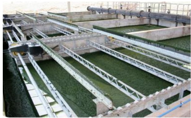
Polimento final (efluente da ETE Santa Maria e ETE Alagado)
