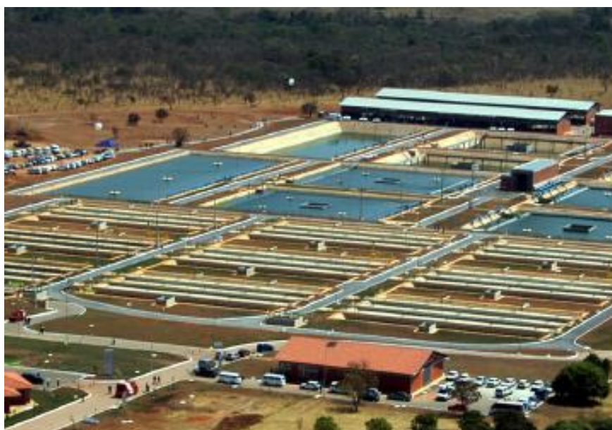
Figura 95 - Vista aérea da ETE Melchior. Fonte: SIESG, 2014.
