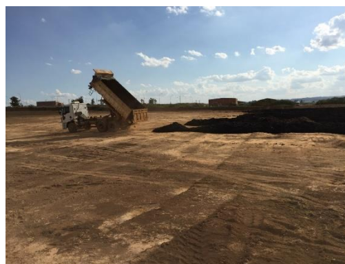
Pátio de secagem recebendo o lodo desidratado
