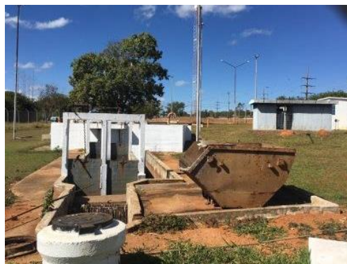
Gradeamento e poço de sucção
