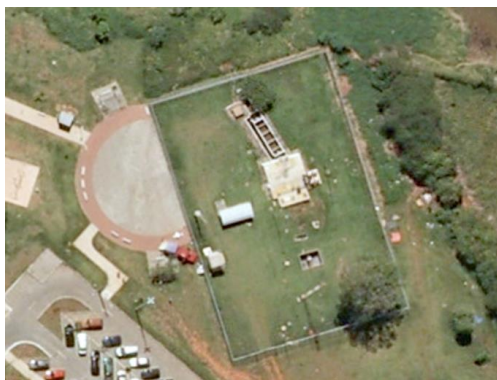
Vista aérea da elevatória
