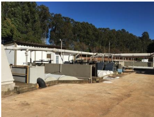
Tubulação para coleta de gás (redução do odor)
