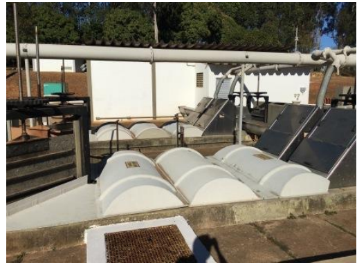
Gradeamento fino no tratamento preliminar
