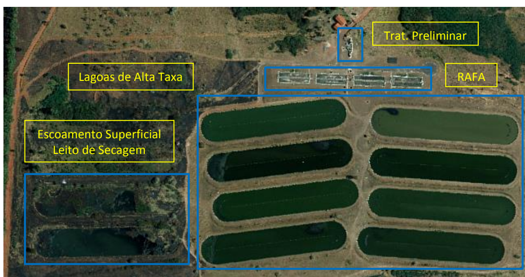
Figura 170 - Área da ETE Santa Maria.
