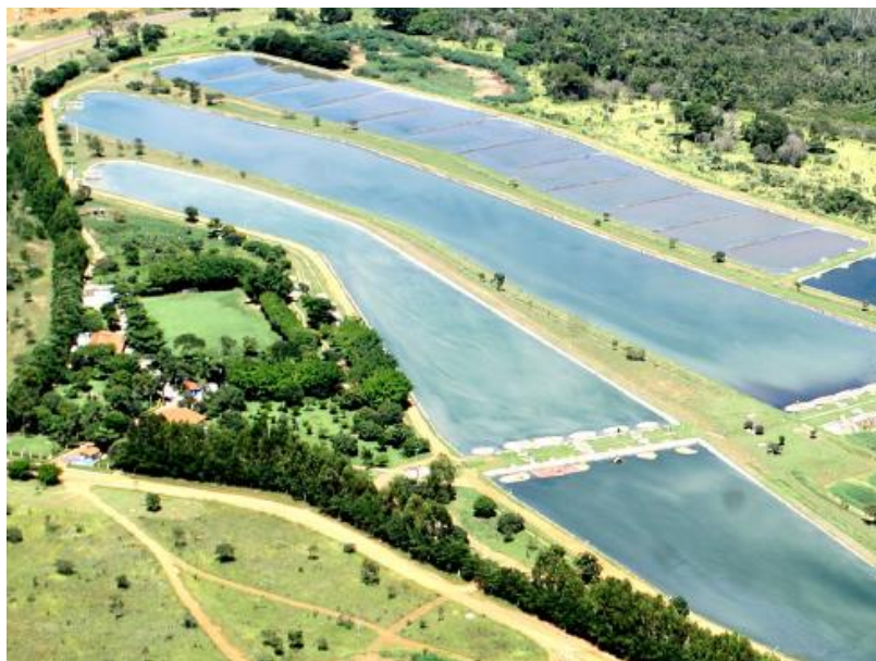
Figura 127 - Vista aérea da ETE Planaltina.
