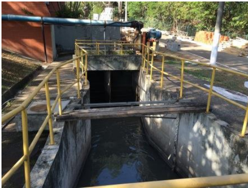
Entrada no poço de sucção
