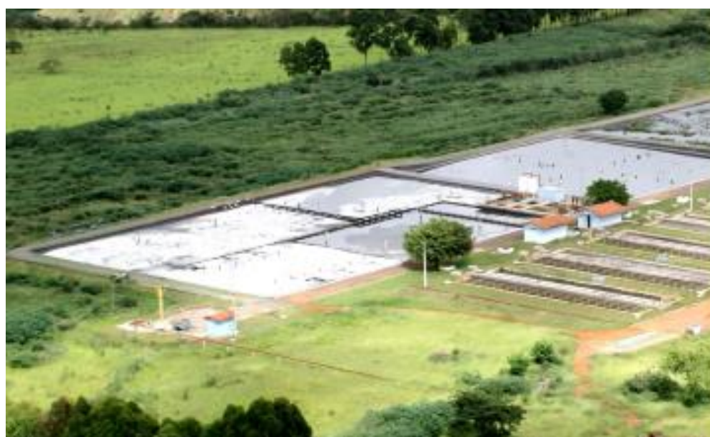
Figura 205 - Vista aérea da ETE Recanto das Emas.
