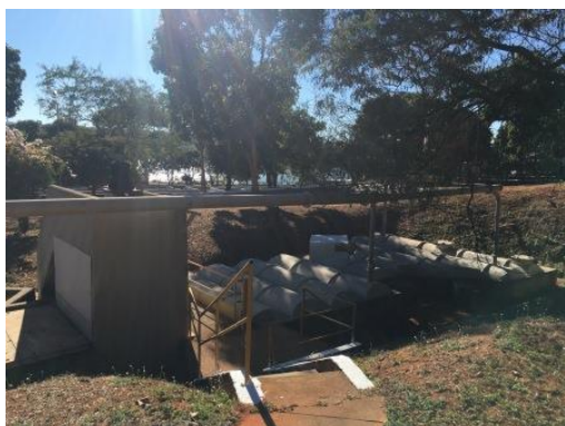
Chegada de esgoto bruto na estação
