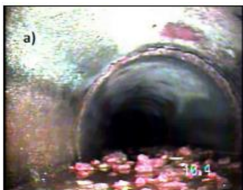
a) Esgoto e assoreamento na rede pluvial
