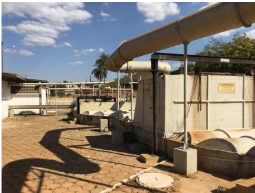
Gradeamento grosso no início do tratamento
