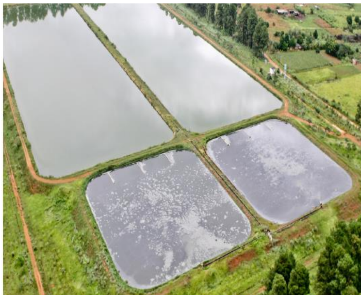
Figura 107 - Vista aérea da ETE Brazlândia.
