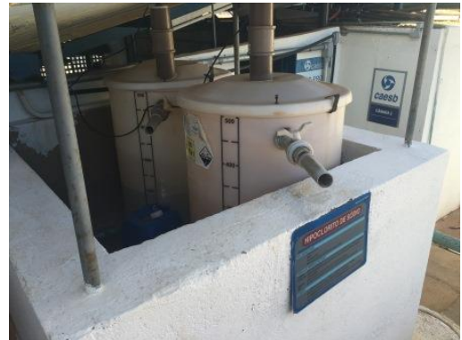
Armazenamento de produtos químicos
