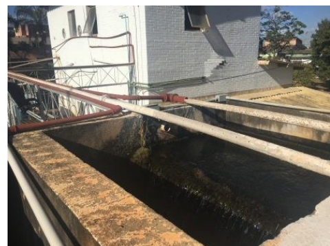
Chegada de água bruta
