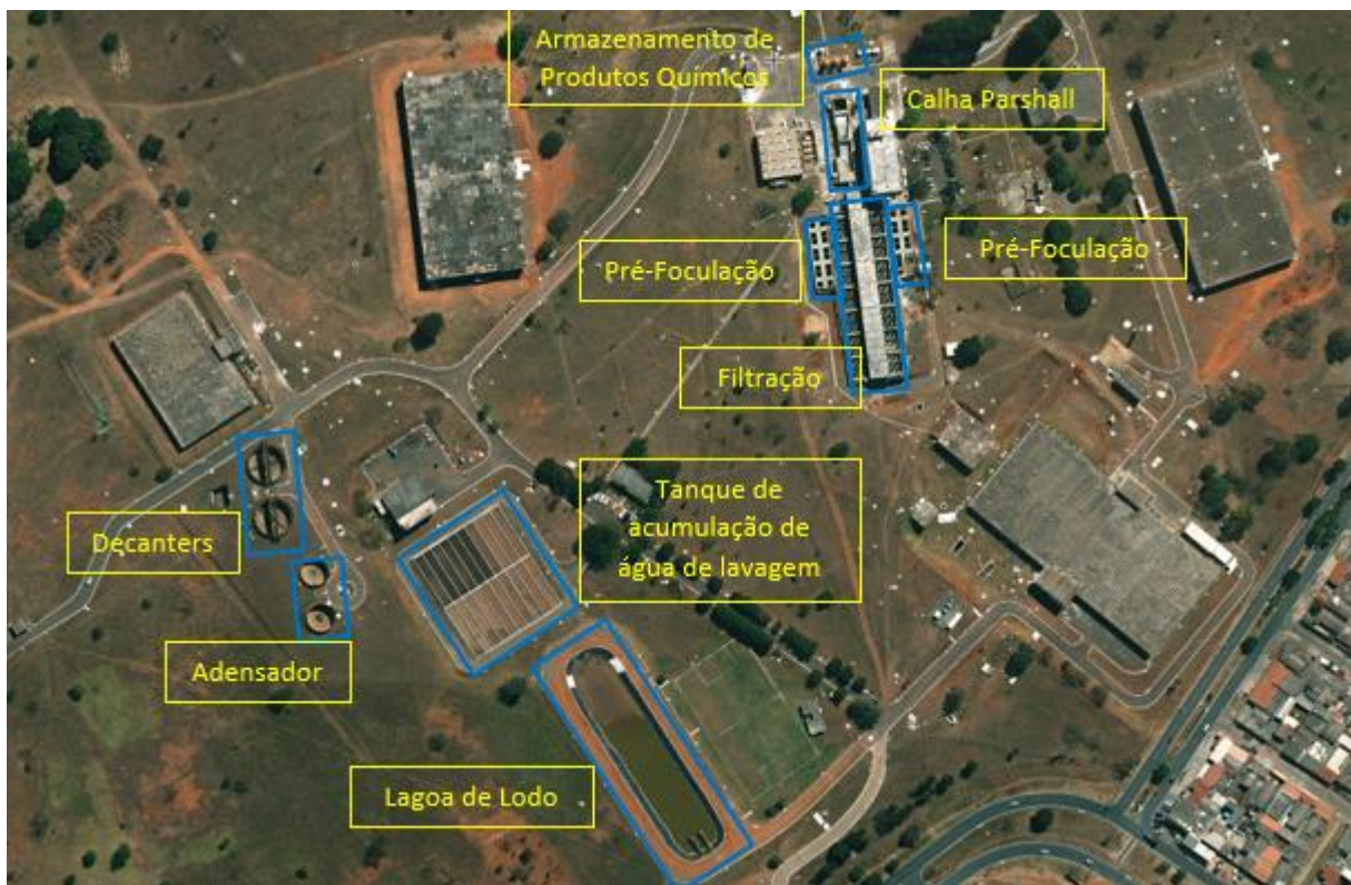
Figura 11 - Vista aérea da ETA Rio Descoberto.
