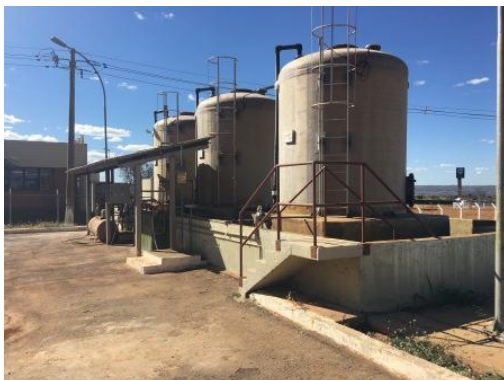
Armazenamento de produtos químicos
