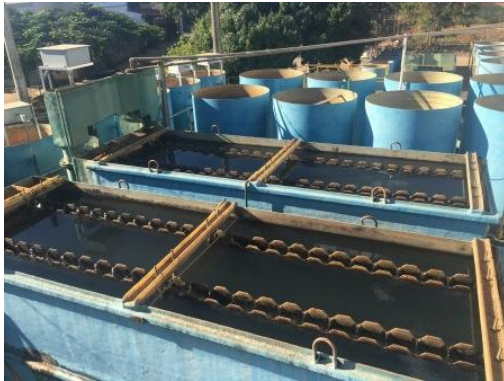
Floculadores e decantadores
