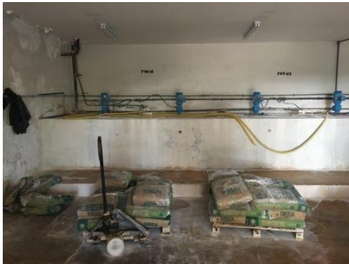
Preparo e dosagem de produtos químicos
