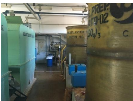
Preparo e dosagem de produtos químicos
