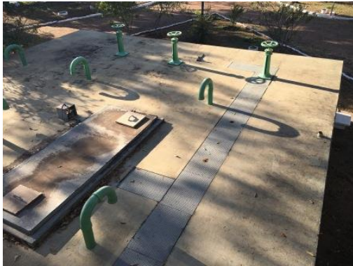
Tanque de contato
