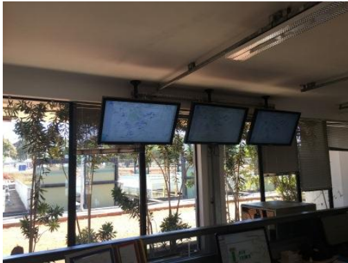
Supervisório de controle da ETA
