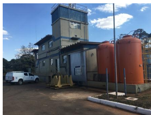
Armazenamento de produtos químicos
