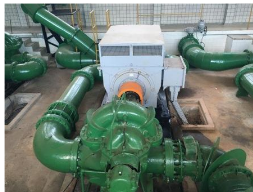
Conjuntos moto-bomba (Torto)
