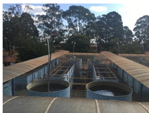
Vista do módulo de tratamento
