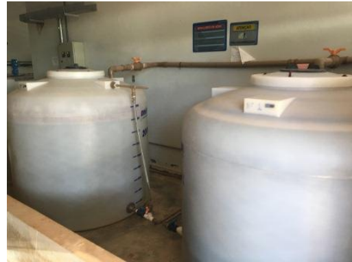
Armazenamento de produtos químicos
