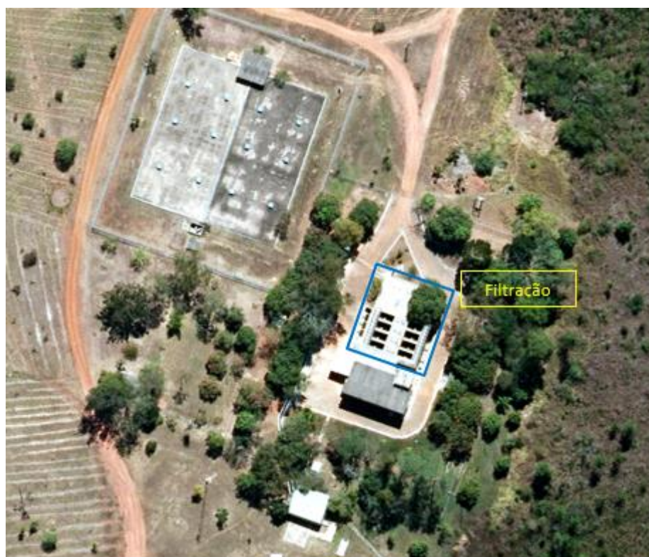
Figura 11 - Vista aérea da ETA Lago Sul.
