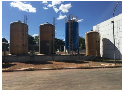
Armazenamento de produtos químicos
