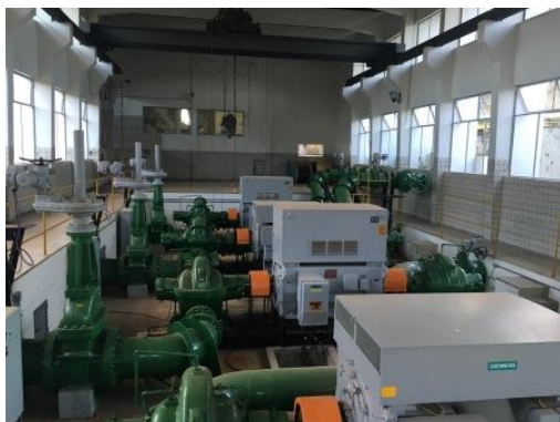
Conjuntos moto-bomba (Torto)
