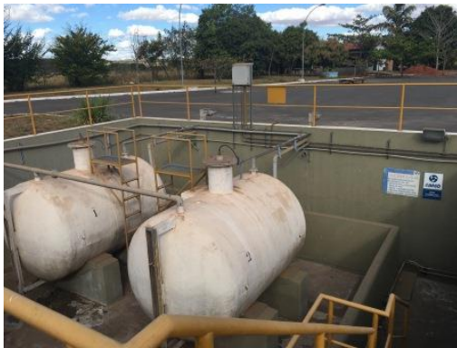
Armazenamento de produtos químicos
