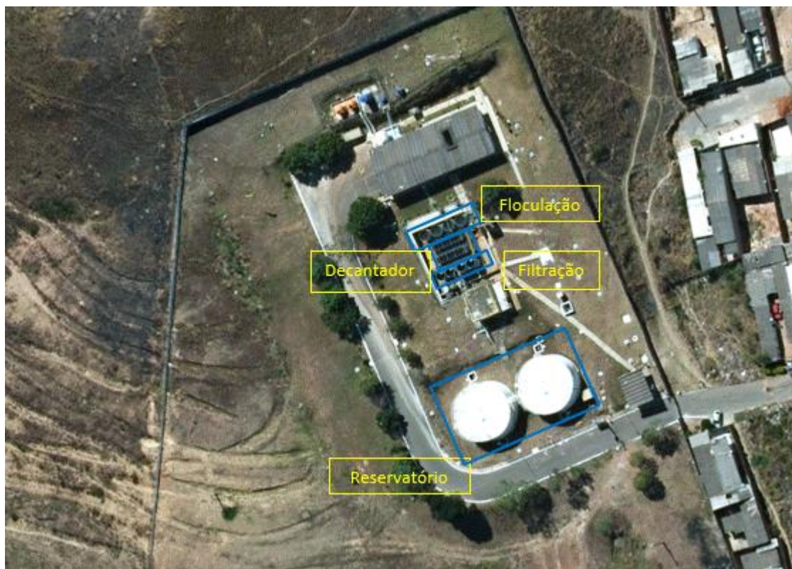
Figura 11 - Vista aérea da ETA Vale do Amanhecer.
