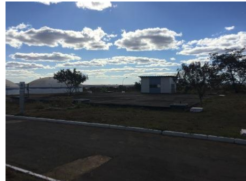
Tanque de equalização da água de lavagem dos filtros
