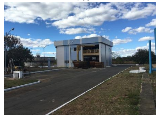
Prédio de desidratação do lodo
