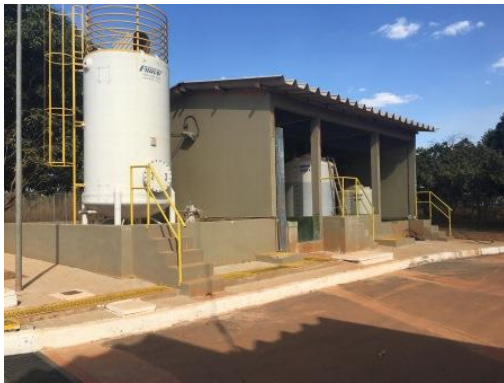
Armazenamento de produtos químicos
