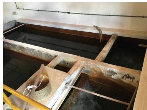
Tanque de contato
