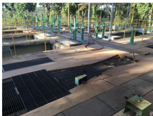
Calha Parshall e filtros
