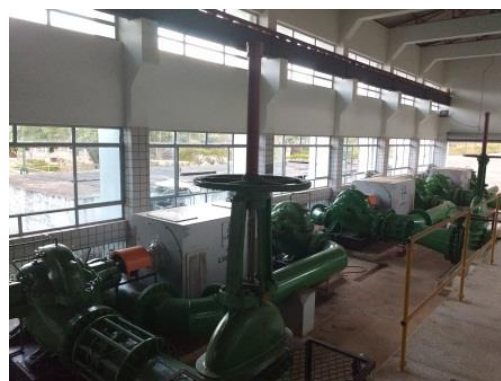
Conjuntos moto-bomba (Santa Maria)
