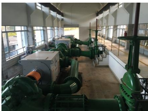
Conjuntos moto-bomba (Santa Maria)
