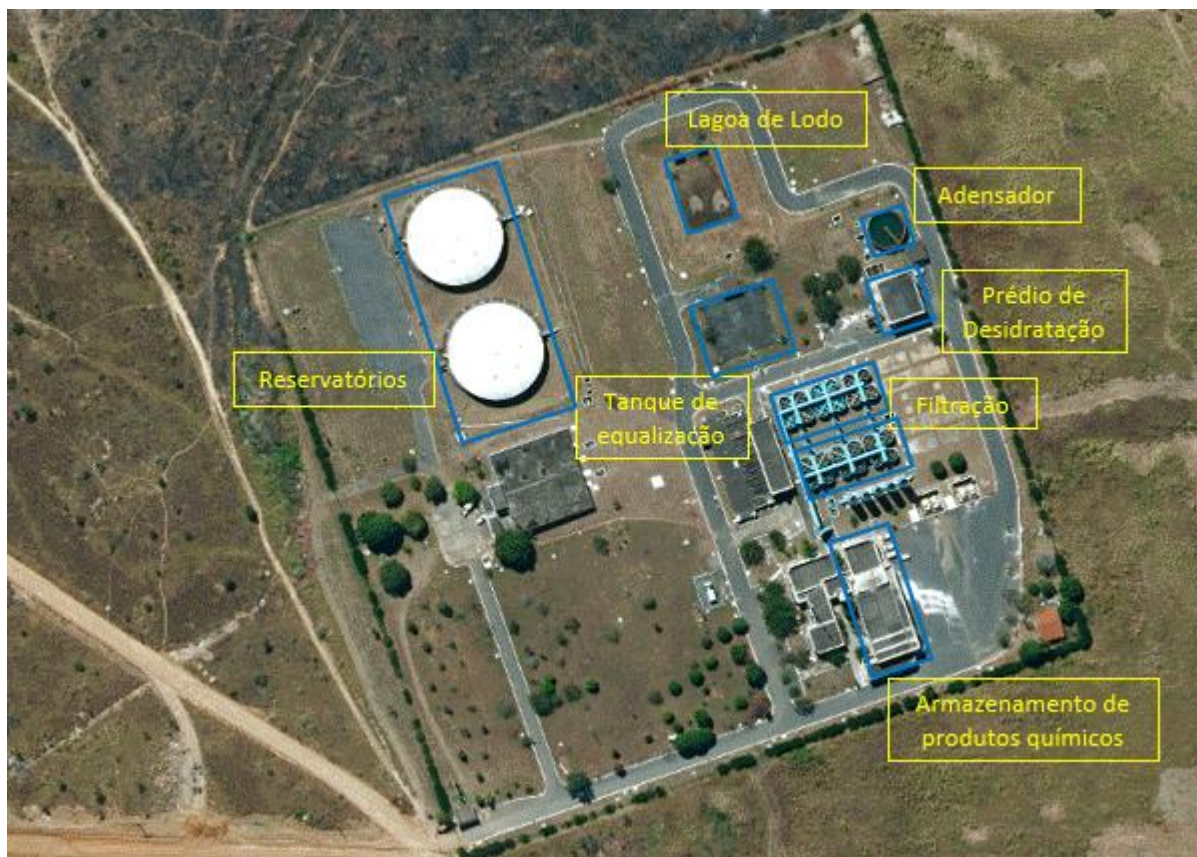
Figura 11 - Vista aérea da ETA Pipiripau. Fonte: Adaptado do Google Earth, 2016.
