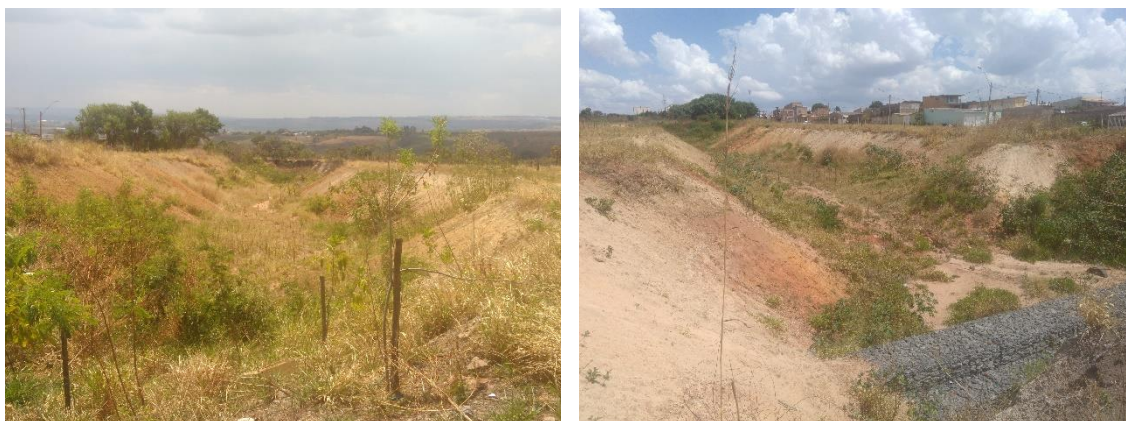
Figura 87 - Erosões em Ceilândia (Condomínio Privê) - situação atual.
