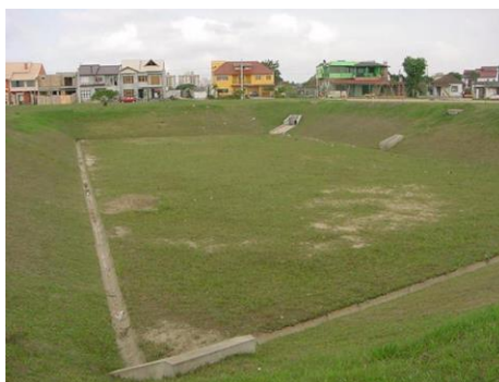
Figura 83 - Reservatórios de detenção em Porto Alegre.
