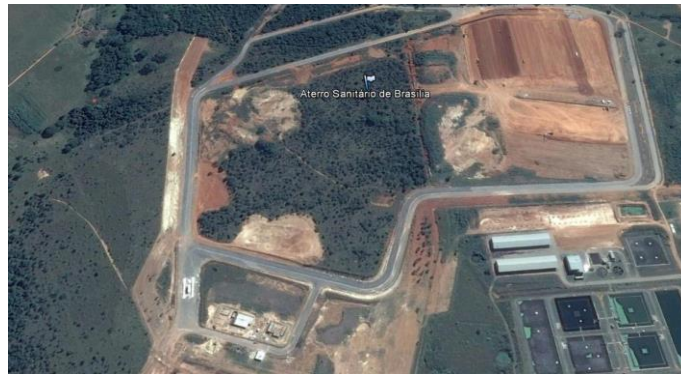
Figura 111 - Aterro Sanitário de Brasília (Lat. 15°51'32.62"S; Long. 48° 9'19.45"O). Fonte: SERENCO.
