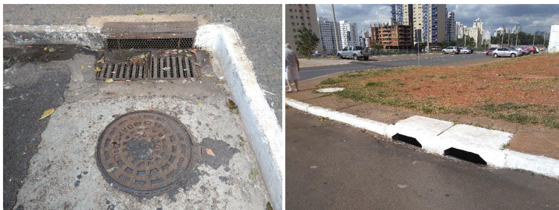
Figura 37 - Componentes da microdrenagem no DF.
