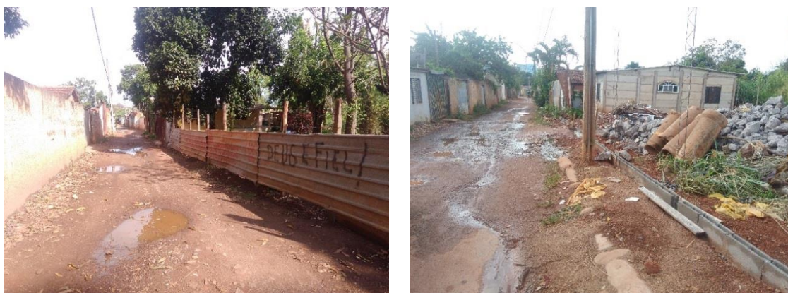
Figura 55 - Área de risco de enchente (Vila Cauhy).
