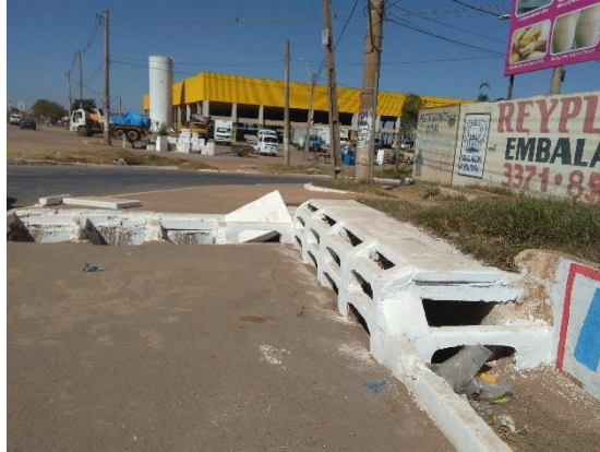
Figura 38 - Soluções improvisadas para a falta de equipamentos de microdrenagem (Ceilândia).
