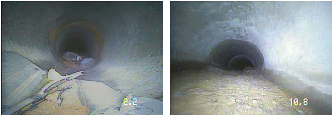
Figura 56 - Tubulação de drenagem pluvial obstruída com resíduos (Quadra 613 Asa Sul).
