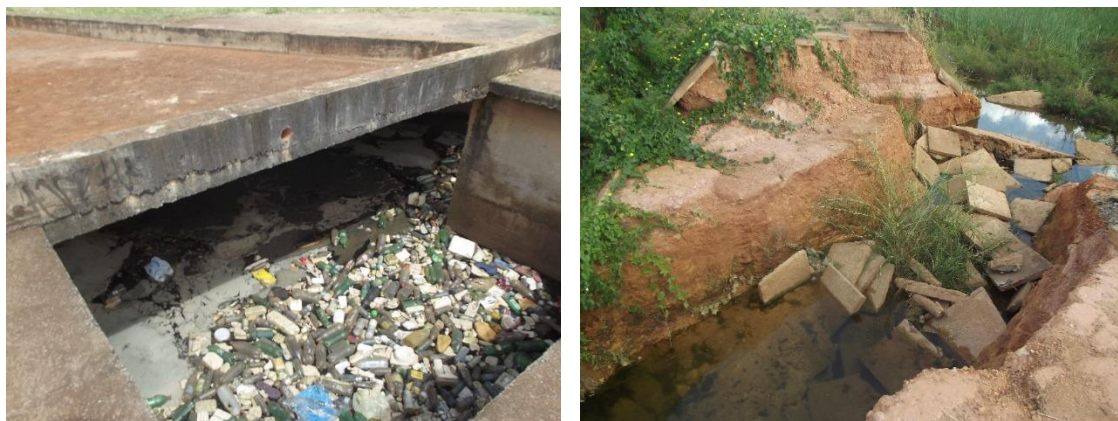
Figura 47 - Problemas de limpeza e manutenção dos reservatórios de detenção.
