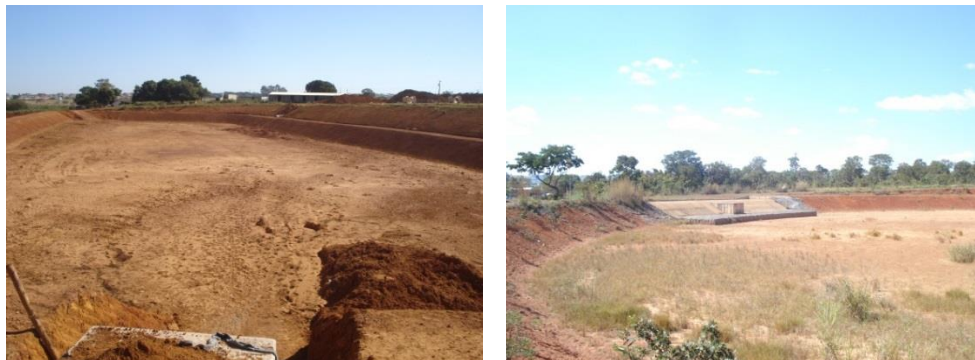
Figura 81 - Reservatórios de Detenção - Sol Nascente (Ceilândia) e Noroeste (Plano Piloto).
