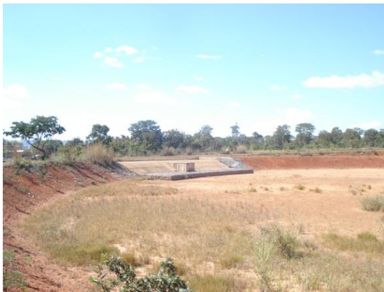
Vertedor de jusante
