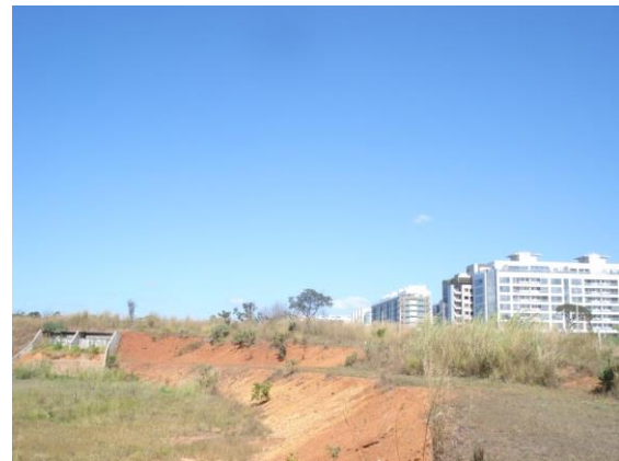
Nordeste - Reservatório de Detenção - Dissipador de Energia
