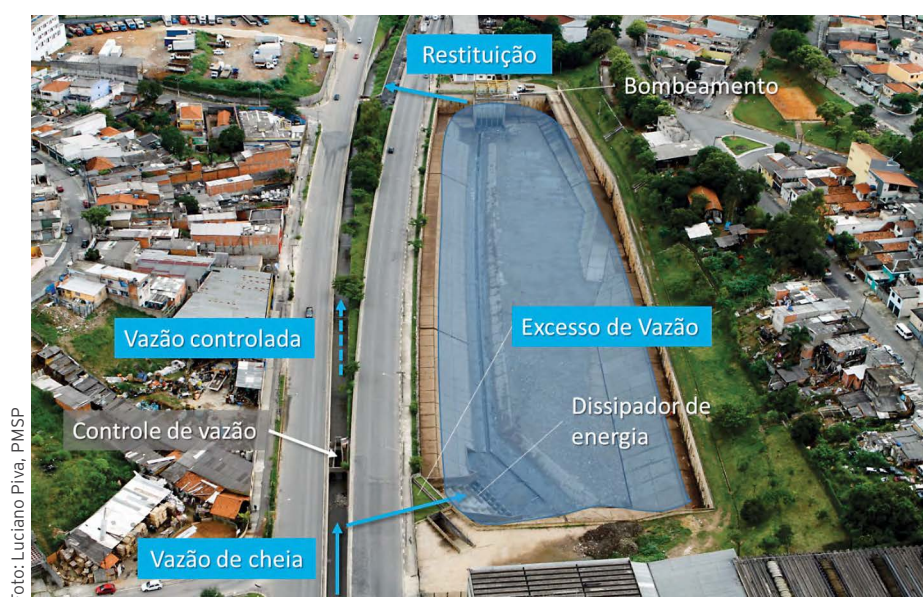
Figura 106 Reservatório off-line Inhumas, em São Paulo.
