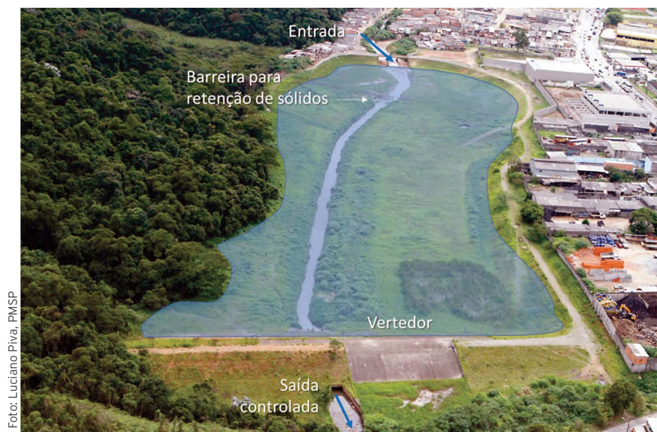
Figura 105 Reservatório in-line , Aricanduva 2, em São Paulo.
