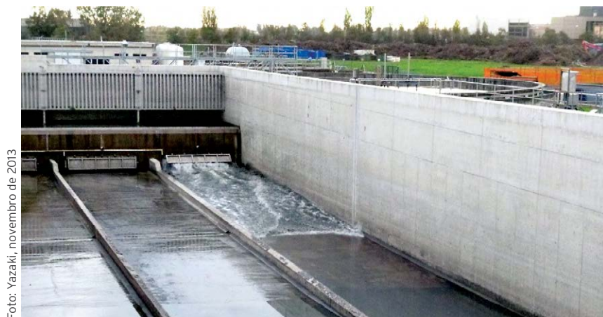
Figura 147 Reservatório de água de primeira chuva com sistema hidráulico automático de remoção de sedimentos em Milão, Itália.
