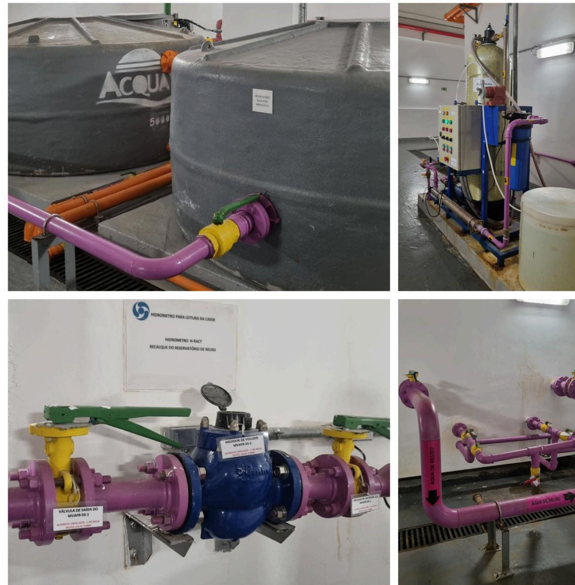
Reservatórios de água pluvial; Sistema de tratamento (automação); Hidrômetro para aferição do consumo; Tubulação água de reúso identificado.
