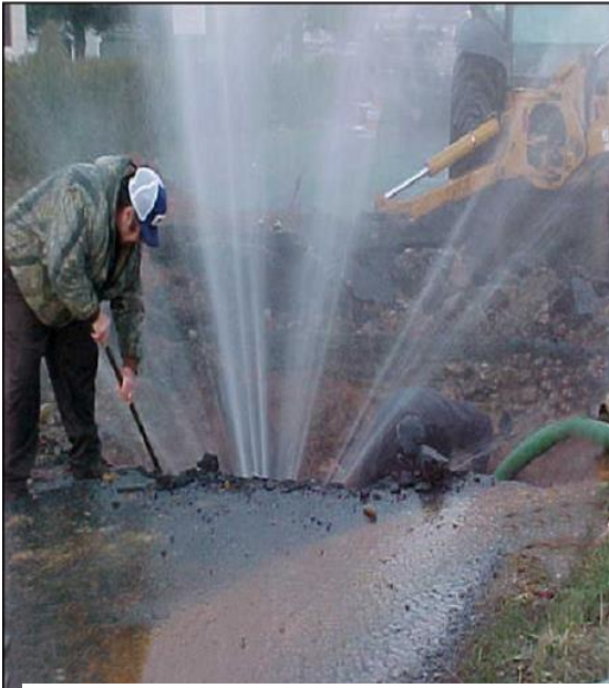
Figura 26 - Efeito da pressão em um vazamento.
