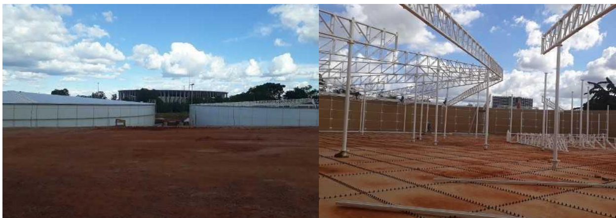
Figura 43 - Fotos da obra das câmaras do RAP.PPL.001.
