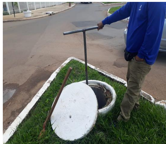
Figura 28 - Manobra na rede de distribuição.
