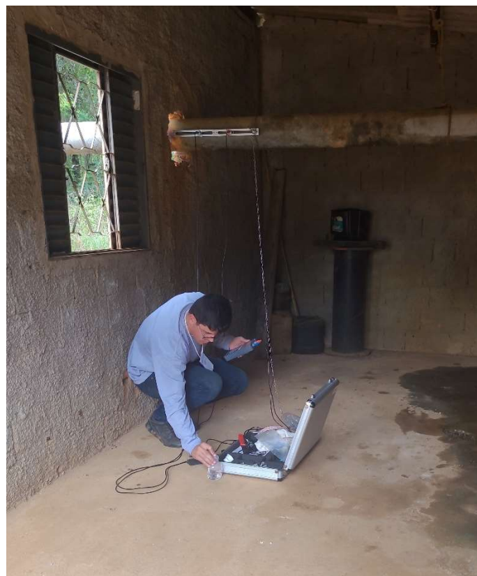
Figura 2.3 – Posicionamento do Par de Transdutores na Tubulação. Fonte: Acervo próprio.
