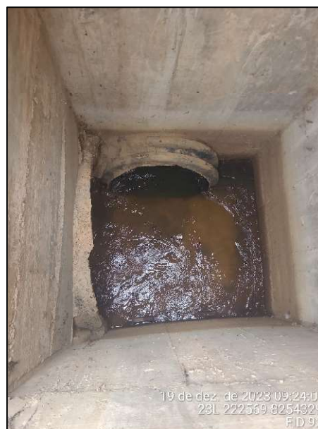
Figura 3.7 - Captação e Poço de Visita (PV). Fonte: Acervo próprio.
