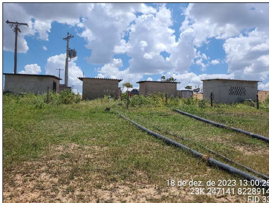
Figura 3.4 – Casas de máquinas das quatro captações do FID 33. Fonte: Acervo próprio.
