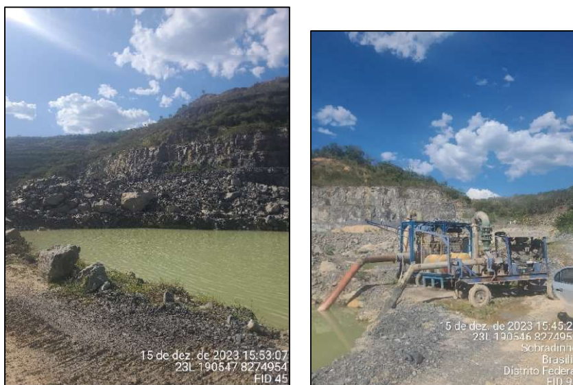
Figura 3.5 – Bacia de acúmulo de água pluvial proveniente das cavas. Fonte: Acervo próprio.
