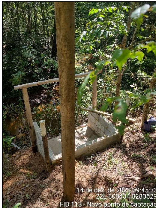
Figura 3.9 - Local para a instalação do conjunto motor-bomba. Fonte: Acervo próprio.
