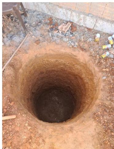
**Figura 12** | Processo de perfuração de “Fossa” sem seguir recomendações da NBR 7.229 (Ch. 48 – Pôr do Sol).
