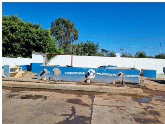
**Figura 18** | Pontos específicos para o descarte de lodos de fossas e gordura.
