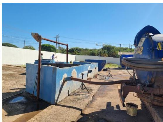
**Figura 20** | Detalhe do mangote no local destinado ao descarte para lodo de fossas.
