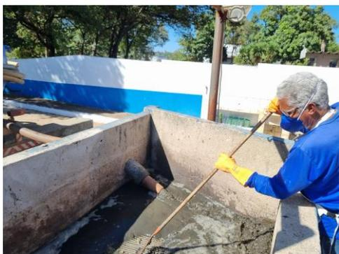
**Figura 21** | Operador da CAESB limpando o gradeamento de chegada do lodo.
