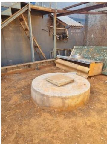
**Figura 13** | “Fossa”<sup>18</sup> com uma câmara, sem sumidouro (Ch. 48 – Pôr do Sol).
