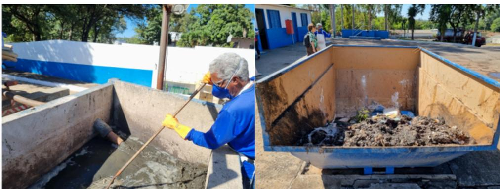
**Figuras 11 e 12:** Operador da CAESB limpando o gradeamento de chegada do lodo; Caçamba de descarte do material gradeado e retirado manualmente.
