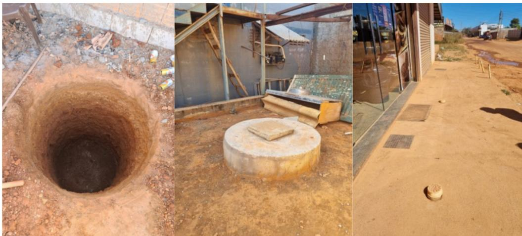
**Figura 1, 2 e 3:** Processo de perfuração de “Fossa” sem seguir recomendações da NBR 7.229 (Ch. 48 – Pôr do Sol); “Fossa”<sup>1</sup> com uma câmara, sem sumidouro (Ch. 48 – Pôr do Sol); “Fossa” em estabelecimento comercial (Assentamento 26 de Setembro).
