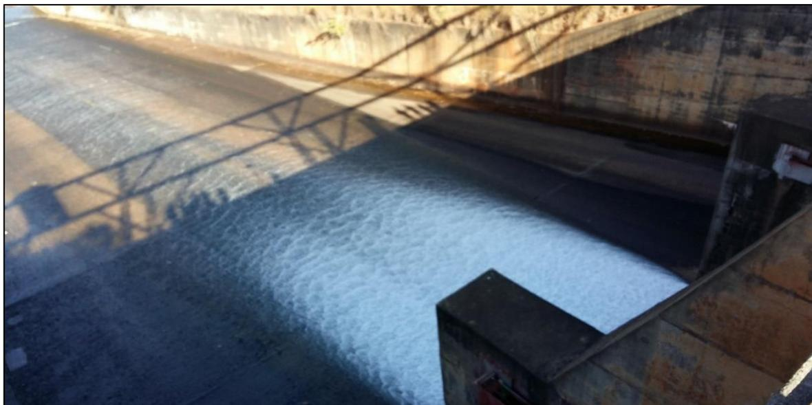
Figura 35: Teste de abertura de 1,5 cm de uma das comportas da barragem do Paranoá.
