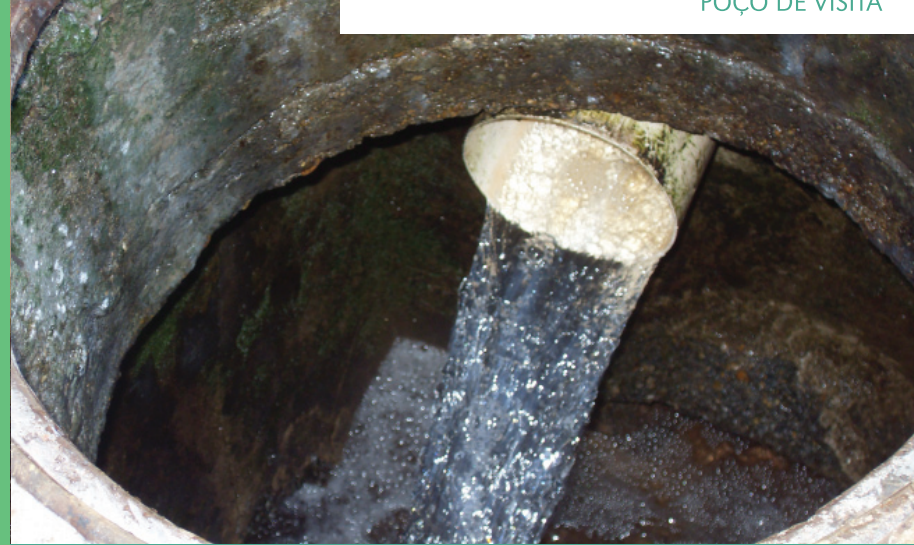
POÇO DE VISITA
