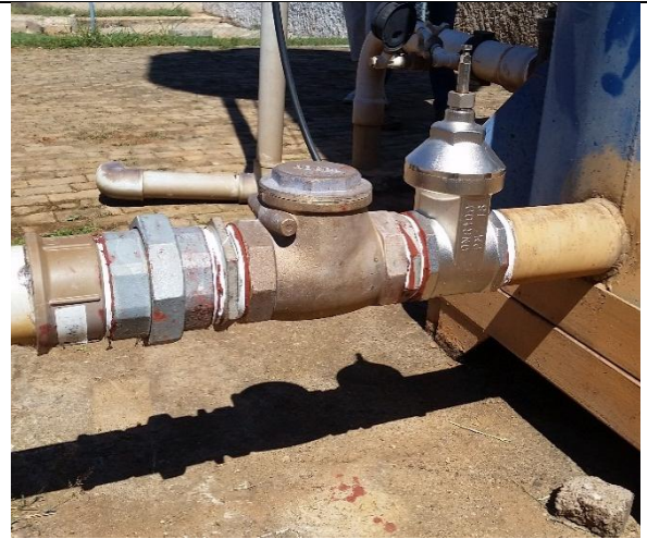
Foto 6 – Válvula trocada e sem sinais de vazamento.
