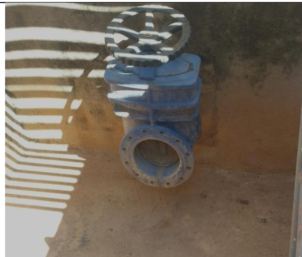
Foto 4 – Base do RAP.SSB.001 sem sinais de vazamento.
