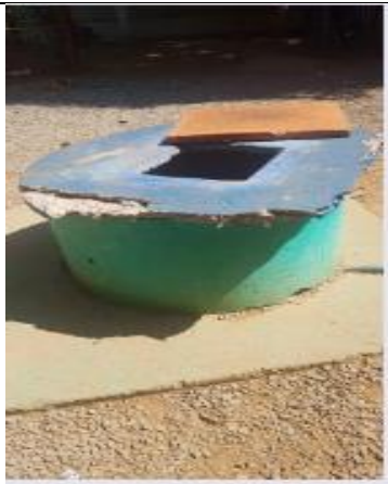
Foto 2 – Poço da escola
