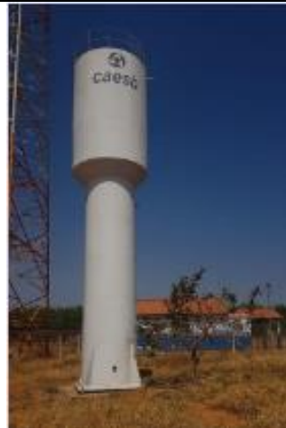
Foto 5 – Caixa d'água da Caesb ao lado do Posto Policial
