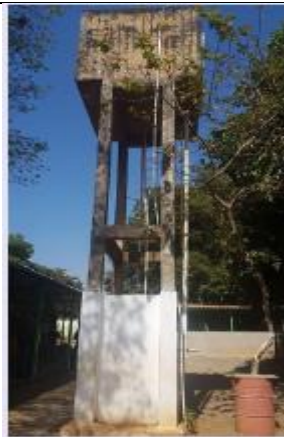
Foto 3 – Reservatório da escola
