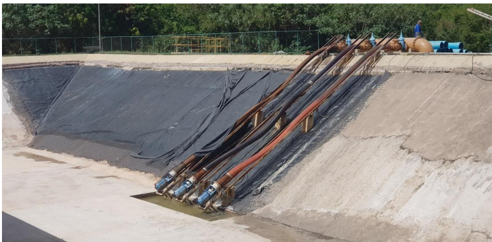
Foto 1: Tanque pulmão sendo revestido
