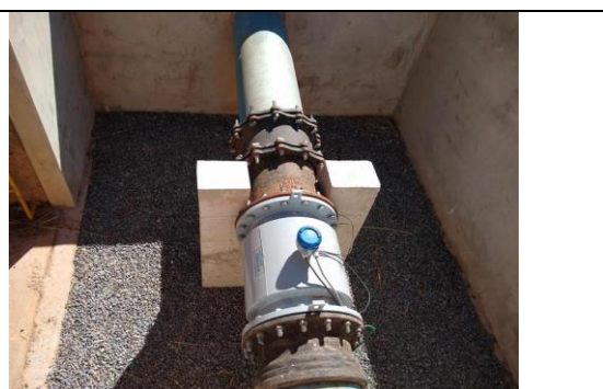
Foto 6 – Tubulação de saída com medidor de vazão
