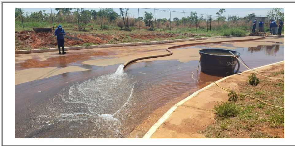
Foto 2 - Esvaziamento da adutora
