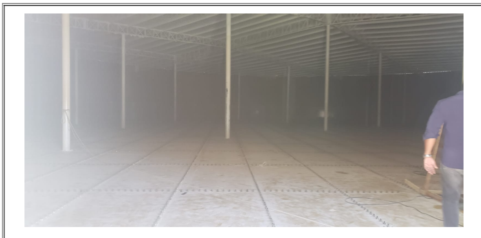
Foto 4 - Reforma do reservatório (vista por dentro)
