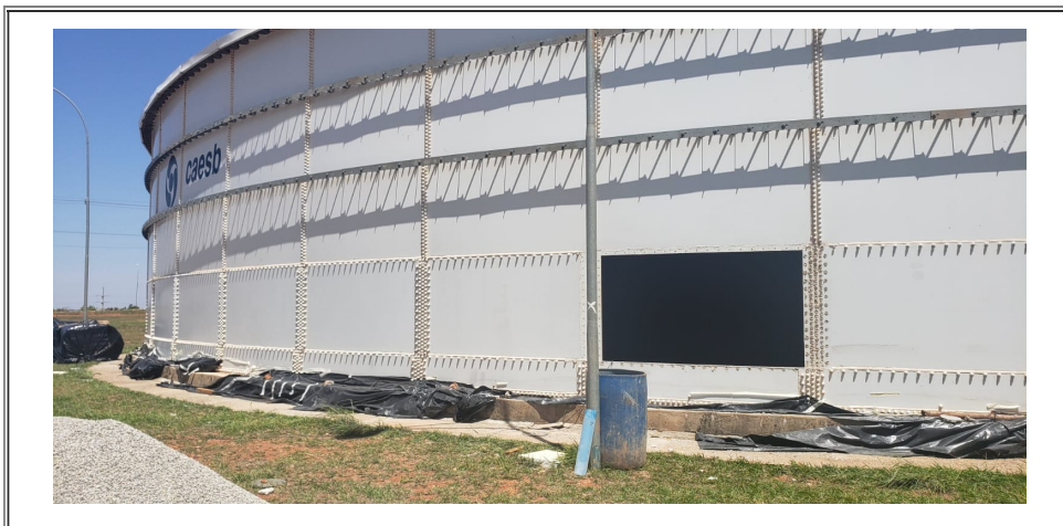
Foto 3 - Reforma do reservatório (vista por fora)
