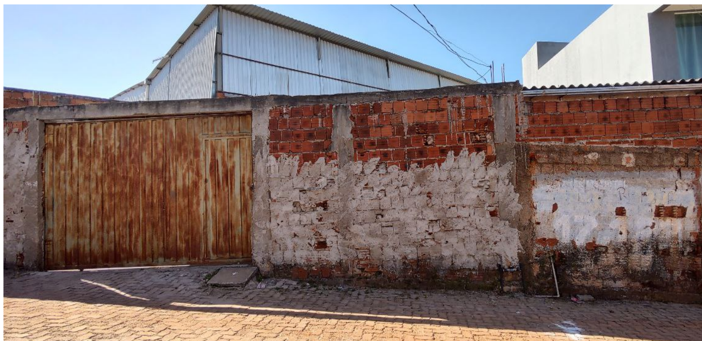
Foto 2: Muro da parte frontal da unidade visitada - Ch 28 casa 01-A Sucupira - Riacho Fundo DF
