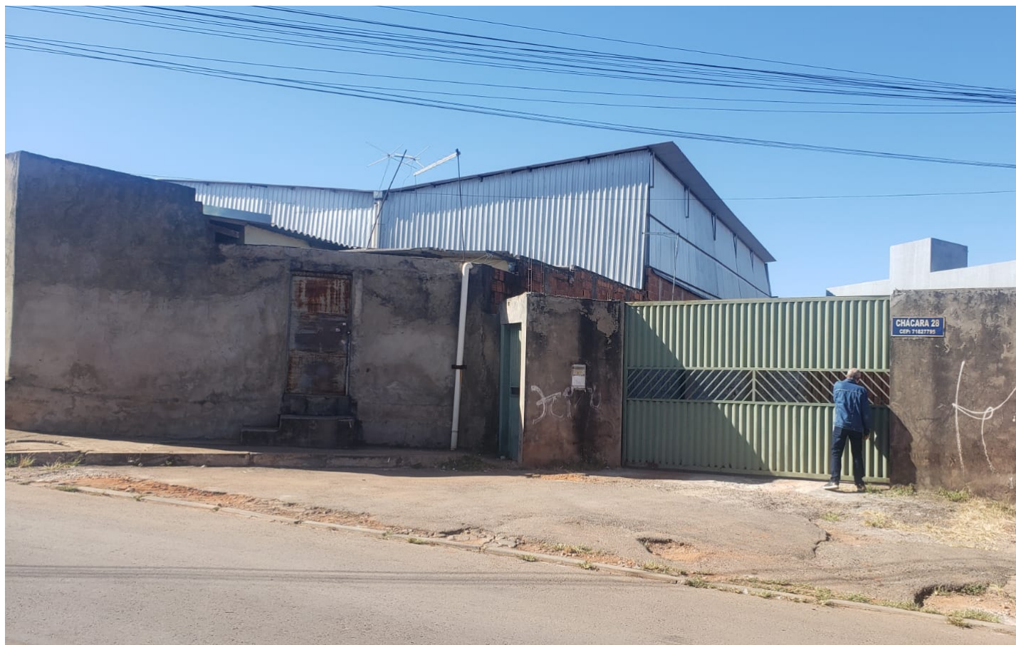
Foto 1: Parte frontal do acesso à Ch 28 - C.A. Sucupira - Riacho Fundo -DF
