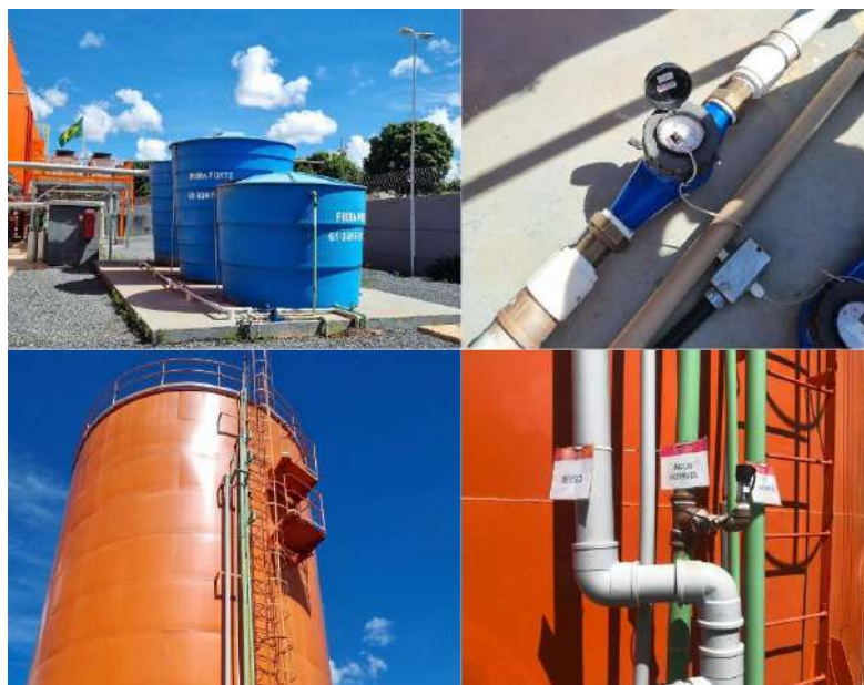
Figura 32 - Principais componentes do sistema não potável do Atacadão Sobradinho
