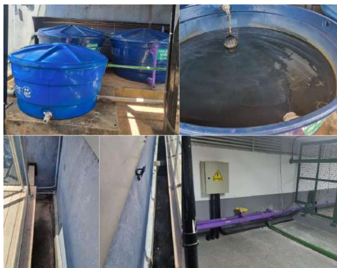
Figura 30 - Principais componentes do sistema não potável do Dataprev
