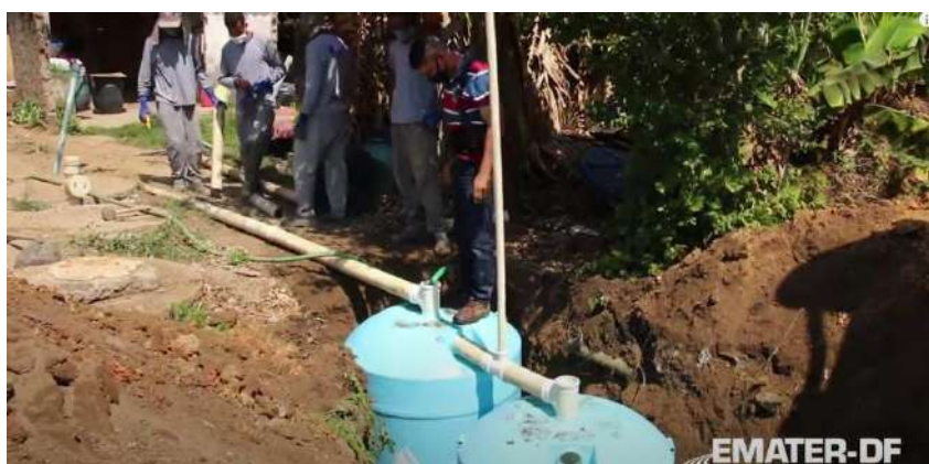
Figura 21 – Instalação de fossas sépticas em propriedades rurais do DF
