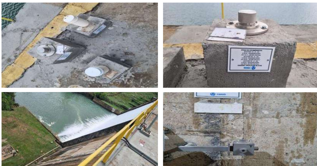
Figura 38 - Melhorias na instrumentação da Barragem do Descoberto
