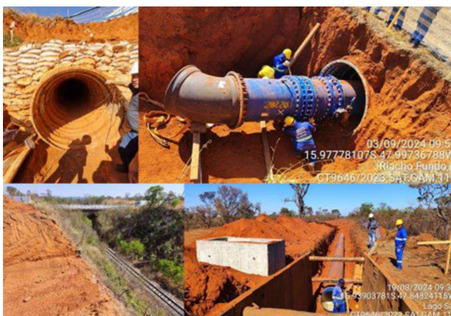
Figura 42 - Execução das Obras dos Trechos de Travessia da Subadutora
