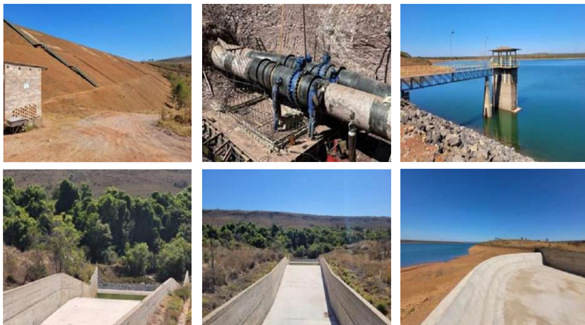
Figura 40 - Obras na Barragem de Santa Maria
