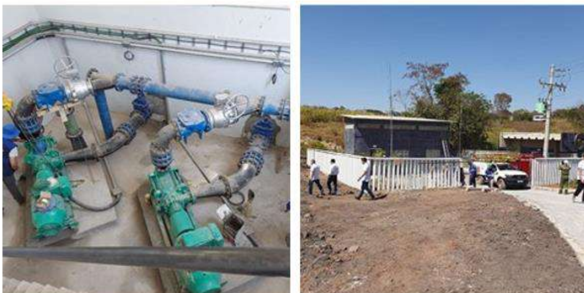
Figura 43 - Implantação de captação no córrego Olaria
