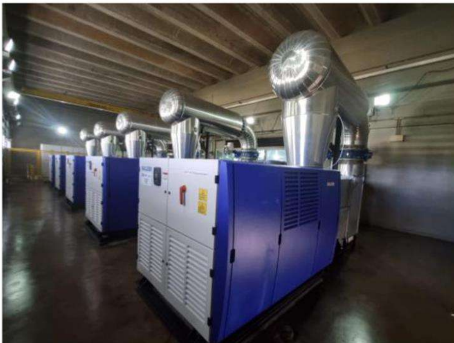
Figura 46 - Novos sopradores de ar para eficiência energética
