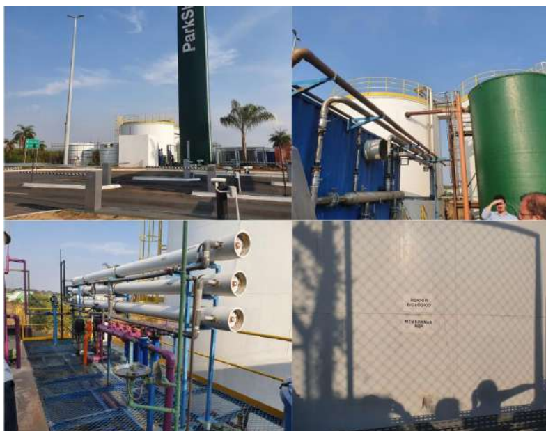
Figura 29 - Principais componentes do sistema não potável do Park Shopping
