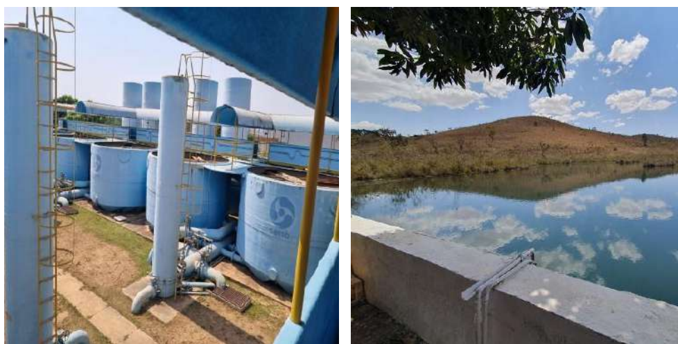
Figura 44 - Vistoria dos sistemas com descontinuidade no abastecimento de água
