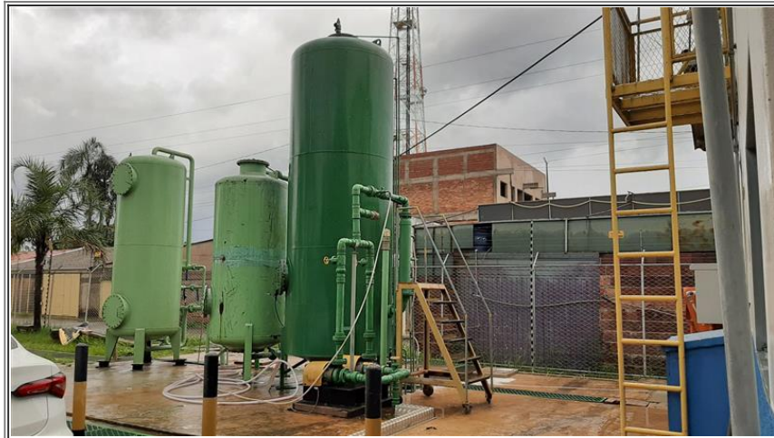
Foto 1 - Estação de Tratamento de Água Engenho das Lajes
