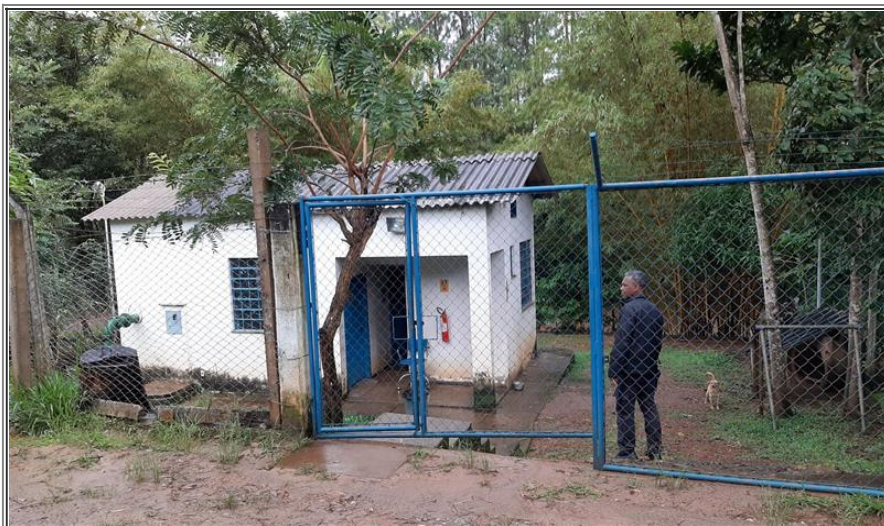
Foto 2 - Estação Elevatória Engenho das Lajes
