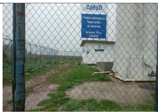
Foto 8 – Reservatório N.R. Rajadinha
