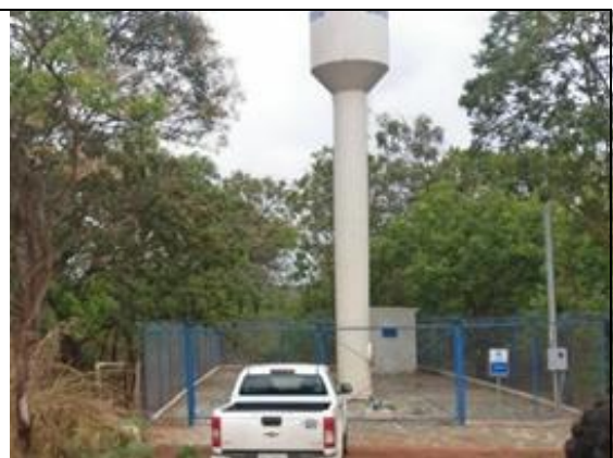
Foto 10 – Reservatório N.R. Monjolo
