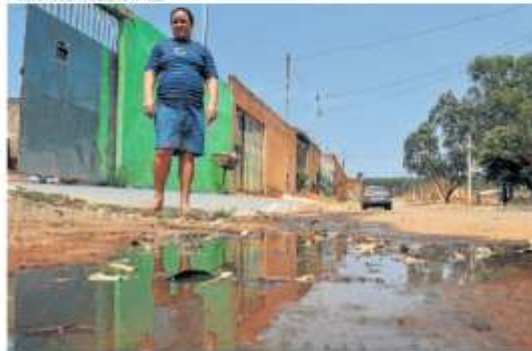
Sem esgoto, Ozenir Leite lava a rua para evitar sujeira na porta de casa
