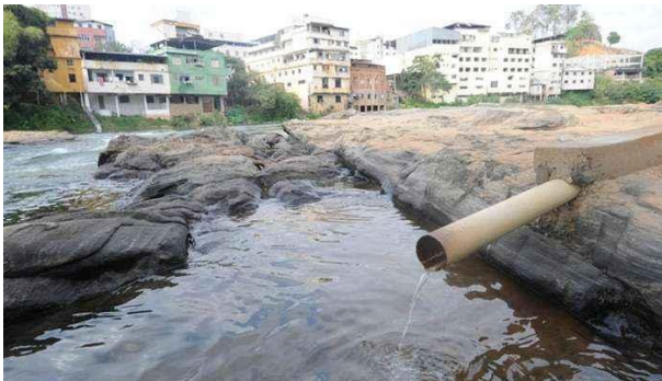
Curso que corta Ponte Nova tem pedras do leito expostas: rio abastece toda a população, da qual recebe 100% dos lançamentos de esgoto
