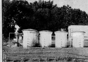
No sistema de tanques, ocorre o tratamento anaeróbico do esgoto
