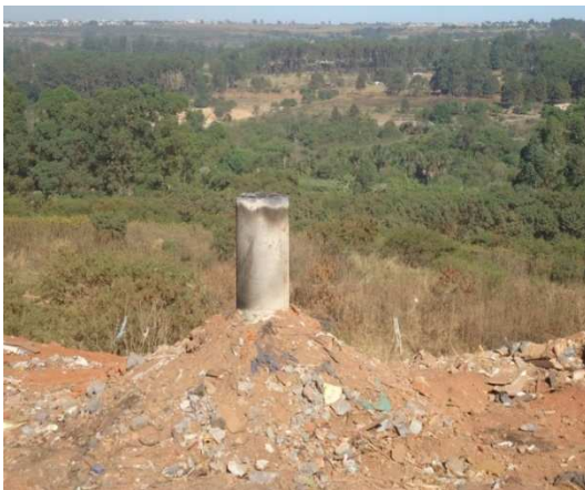
Dreno de gás do maciço
