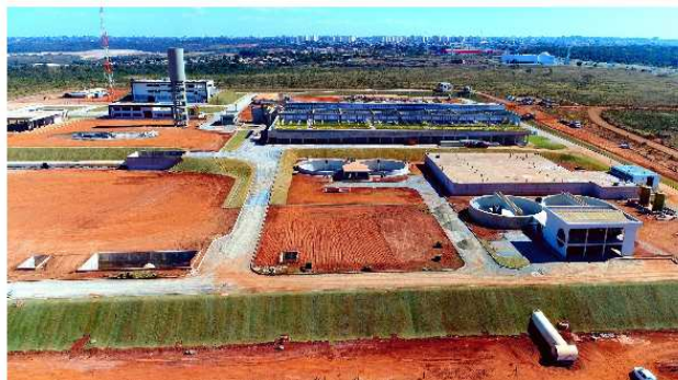
Figura 10.22: Obras na ETA localizada em Valparaíso do Sistema Produtor Corumbá. Fonte: CAESB, 2017.
