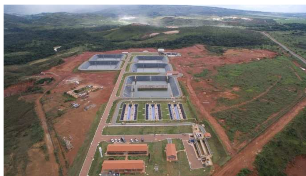
Figura 10.29: ETE Águas Lindas. Fonte: AGUAS LINDAS DE GOIÁS, 2017. 24
