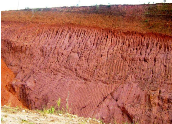
Figura 4.31: Extensa área com afloramento de solo exposto devido a remoção da camada superficial de solo. Fonte: ECODEBATE, 20125.
