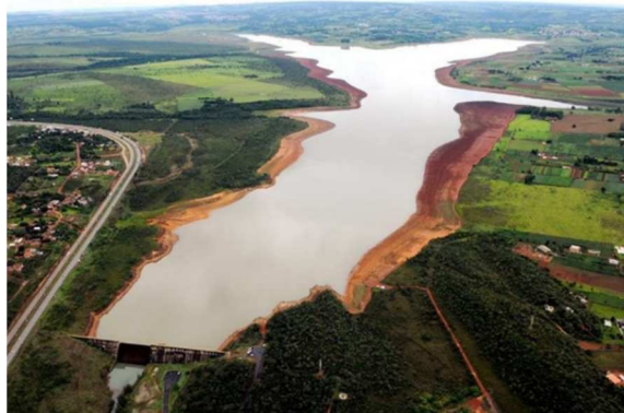
Figura 11.7: Barragem Santa Maria. Fonte: METROPOLES, 2018 27
