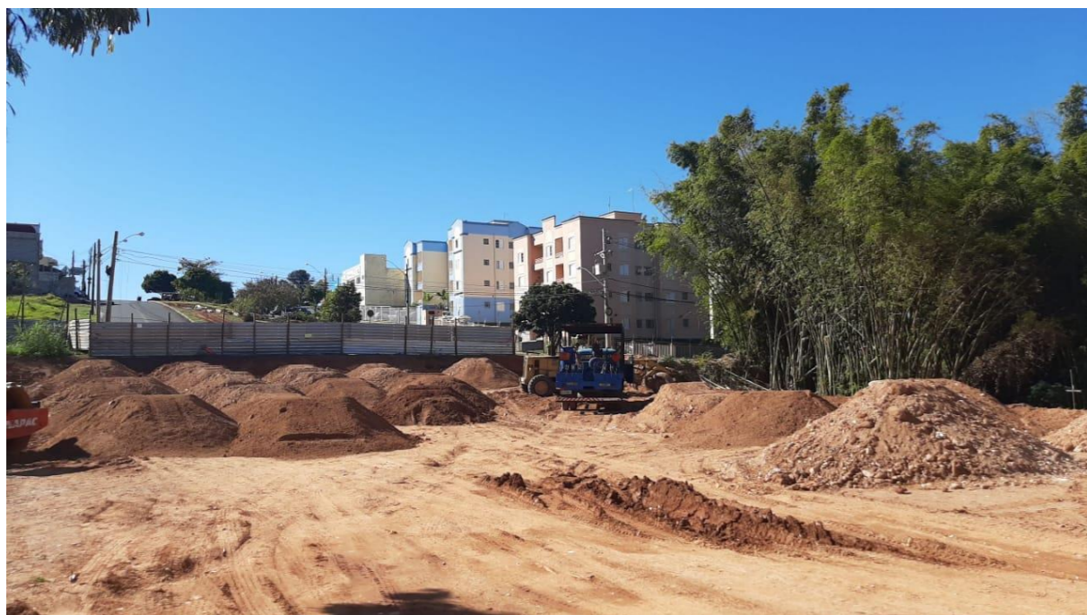
Aterro Controlado com uso de Solo Brita Reciclado
