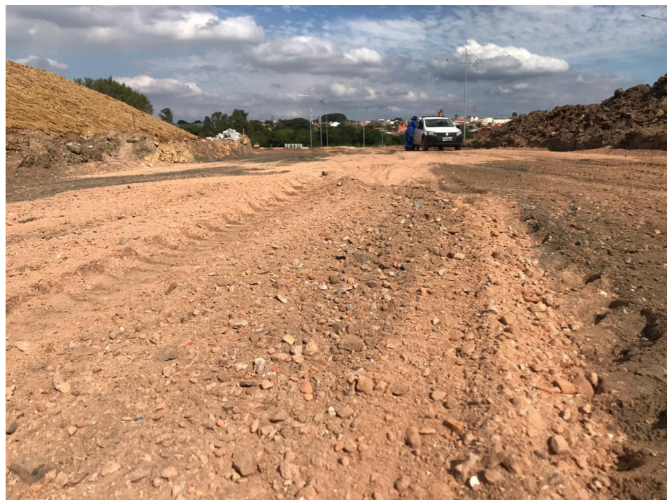
Base de pavimentação asfáltica com uso de BGS reciclado
