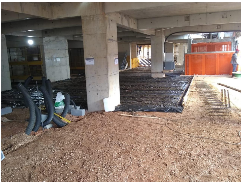
Base de piso em concreto com uso de BGS reciclado
