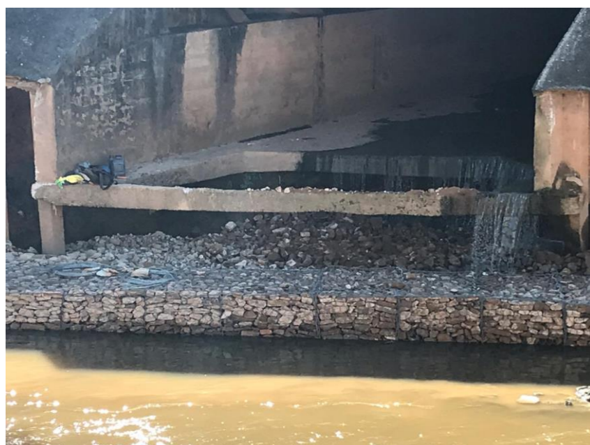
Muro de gabião com uso de rachão reciclado
