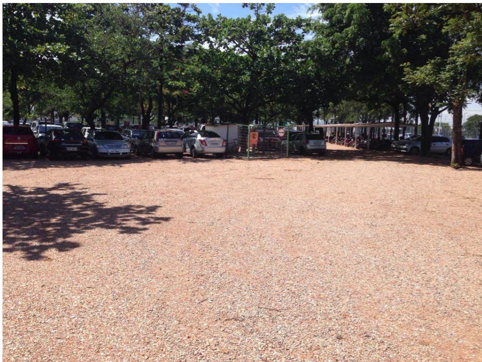
Pátio de estacionamento com uso de BGS reciclado
