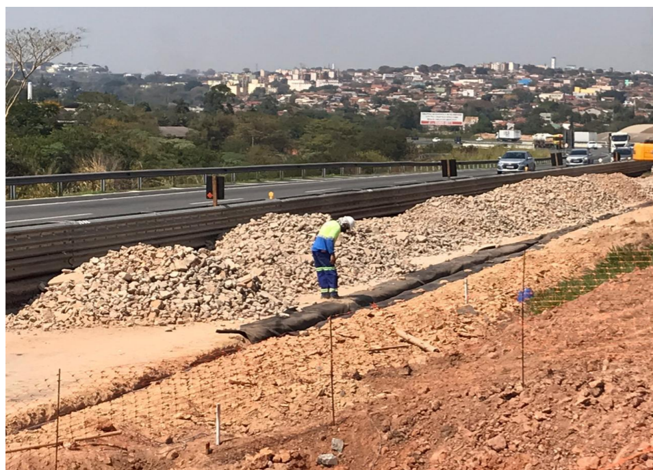
Sub base de pavimentação asfáltica com uso de rachão reciclado – Tabela I CCR Engellog (Rodovia dos Bandeirantes)
