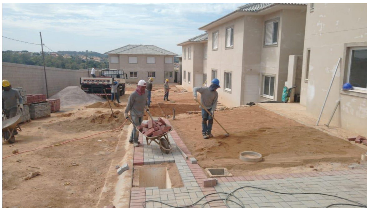
Assentamento de Piso Intertravado com uso de Pó de Pedra Reciclado
