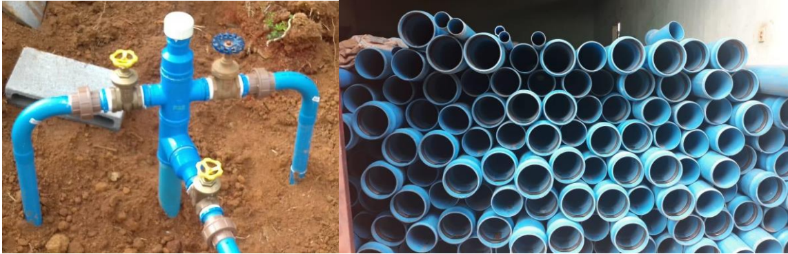
Figura 6- Registros e canos utilizados no revestimento dos ramais secundários do canal Santos Dumont.
