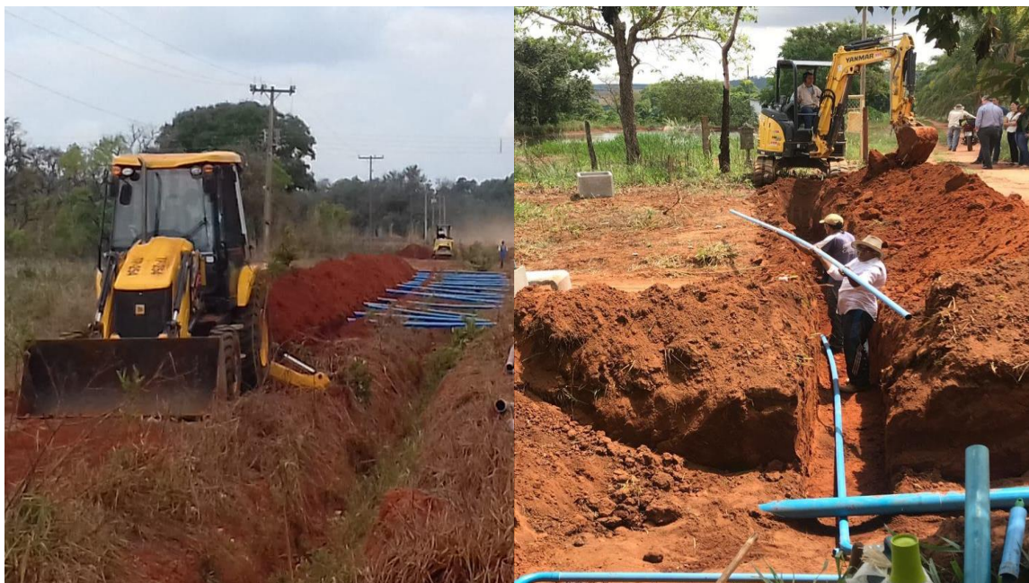
Figura 23 - Obras de revestimento dos ramais secundários do canal Santos Dumont.
