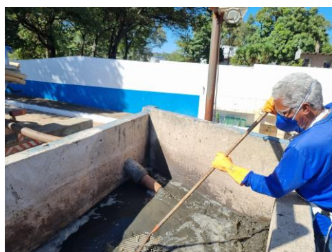
Figura 21 | Operador da CAESB limpando o gradeamento de chegada do lodo.
