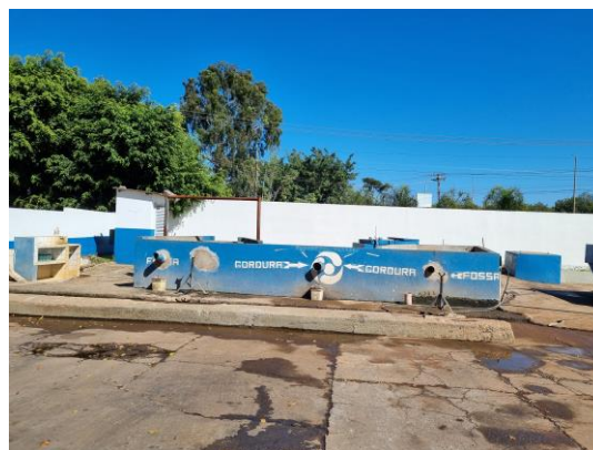
Figura 18 | Pontos específicos para o descarte de lodos de fossas e gordura.
