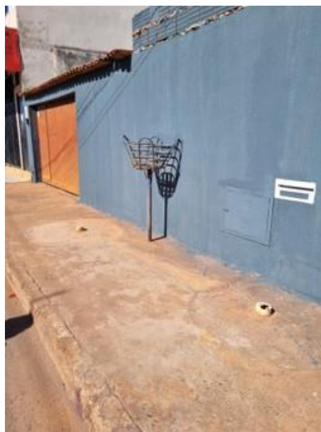
Figura 16 | Saídas de águas de lavagem por tubulação em vias públicas no Nova Colina.
