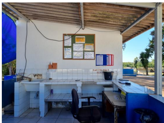
Figura 17 | Sala de controle da CAESB.
