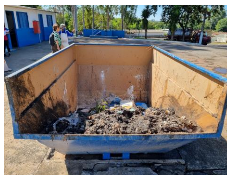
Figura 22 | Caçamba de descarte do material gradeado e retirado manualmente.
