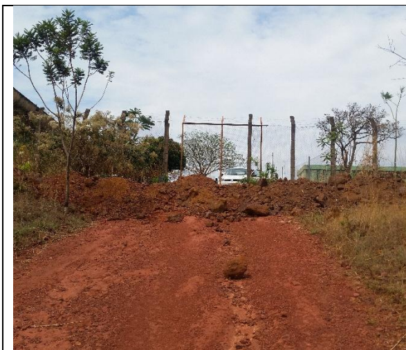
Foto 17 – Acesso à elevatória obstruído (RF/COFA/006/2015)
