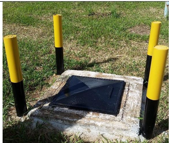
Foto 28 – Nova tampa colocada no poço.
