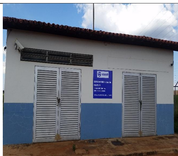
Foto 12 – Placa de advertência nova.
