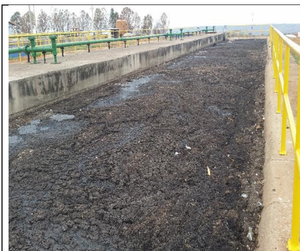
Foto 5 – Acúmulo de lodo na superfície dos reatores (RF/COFA/006/2015)
