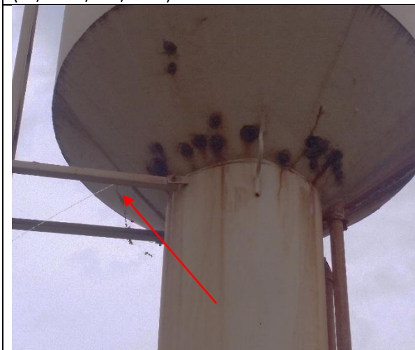
Foto 3 – Vazamento em Reservatório de Água (RF/COFA/006/2015)
