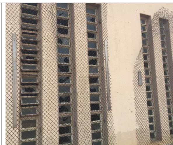
Foto 28 – Vidros quebrados (RF/COFA/006/2015)
