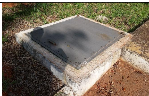
Foto 10 – Tampa do poço de visita substituída.
