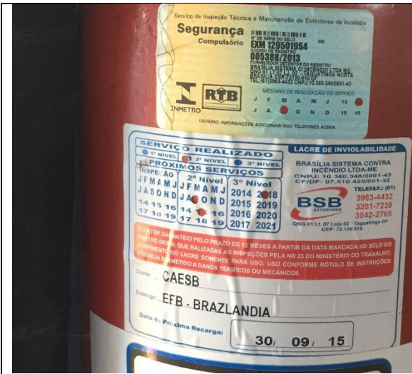
Foto 25 – Extintor de Incêndio vencido (RF/COFA/006/2015)
