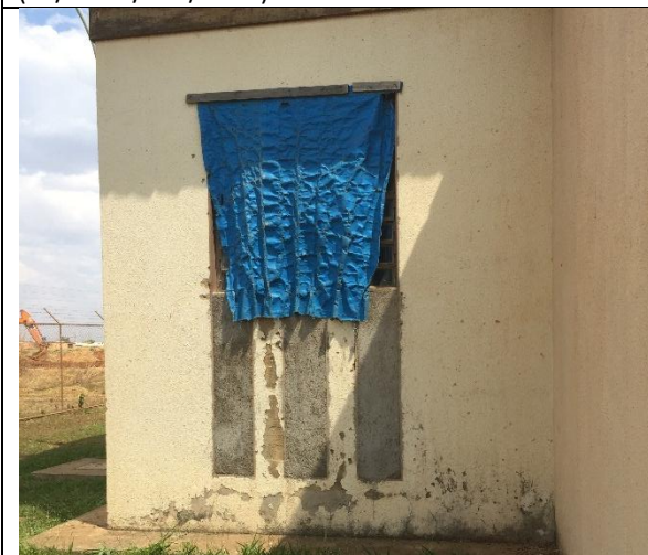
Foto 27 – Janelas quebradas e tampadas com lona (RF/COFA/006/2015).
