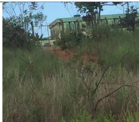
Foto 18 – Acesso à elevatória desobstruído.
