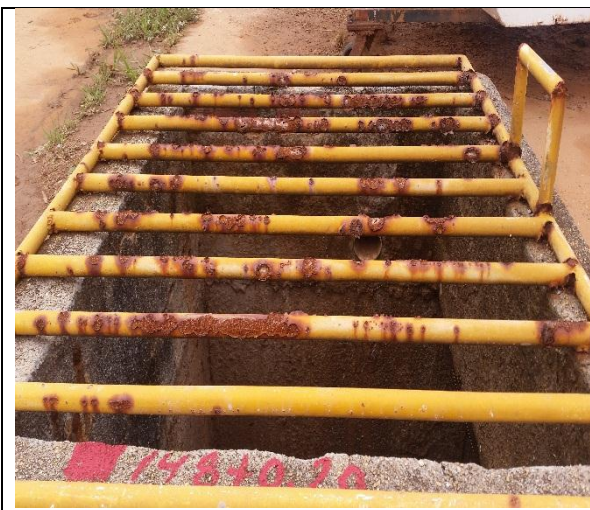
Foto 13 – Grade oxidada (RF/COFA/006/2015)
