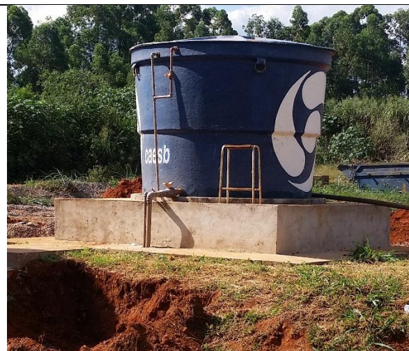
Foto 4 – Reservatório de água novo e sem sinais de vazamento.
