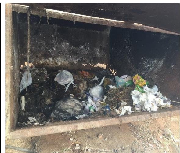
Foto 23 – Caçamba de disposição de lixos grosseiros corroída. (RF/COFA/006/2015)
