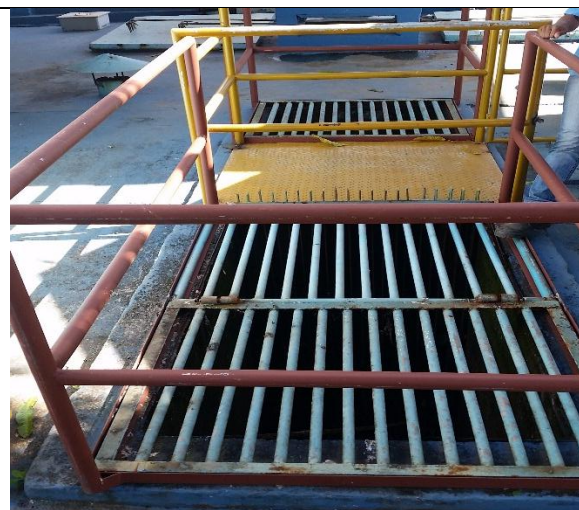
Foto 22 – Grades de proteção recuperadas e com guarda-corpo.
