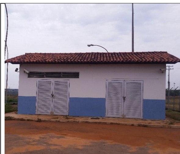
Foto 11 – Vista da EEB.RF2.001 (RF/COFA/006/2015)
