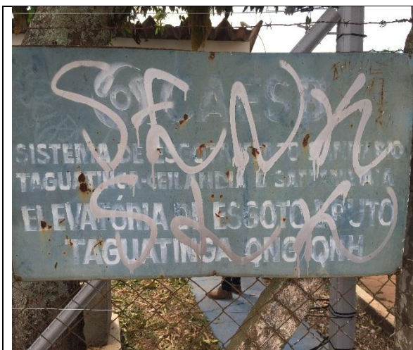
Foto 19 –Placa de advertência depredada (RF/COFA/006/2015)
