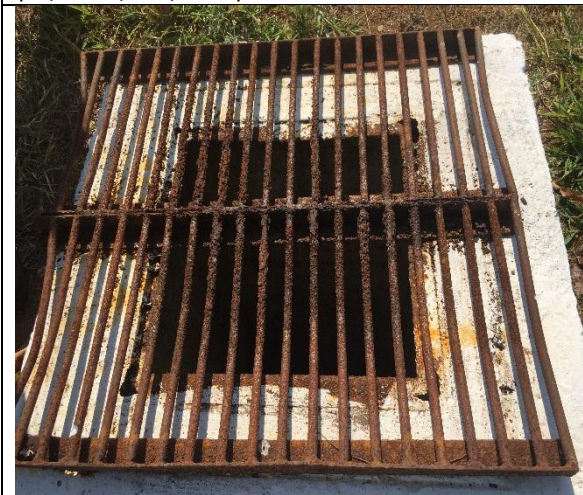
Foto 27 – Grade do poço oxidada (RF/COFA/006/2015).
