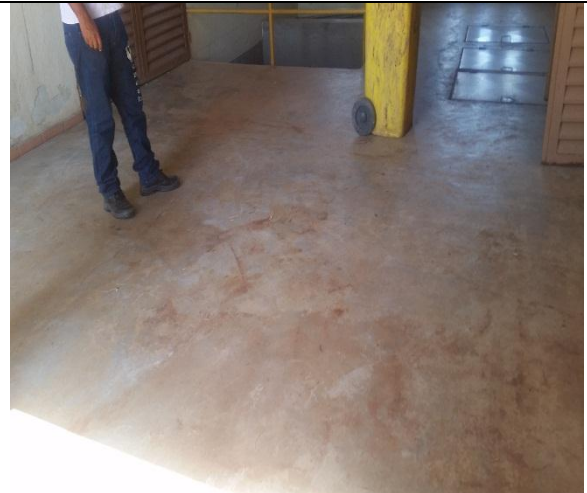
Foto 26 – Chão sem sinais de fezes de aves.
