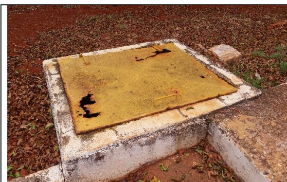
Foto 9 – Tampa do poço de visita com sinais de oxidação (RF/COFA/006/2015)
