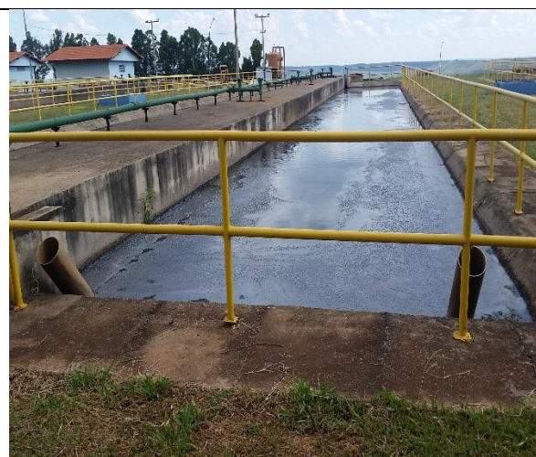
Foto 6 – Reatores sem acúmulo de lodo na superfície.
