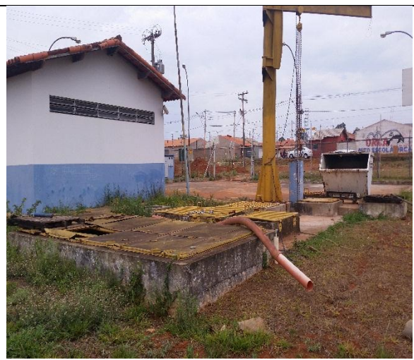
Foto 14 – Tampas danificadas (RF/COFA/006/2015).
