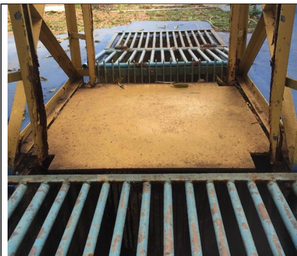
Foto 21 – Grade de proteção com sinais de oxidação (RF/COFA/006/2015).
