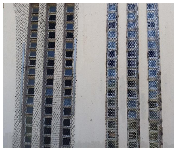
Foto 29 – Vidros e grades trocados.
