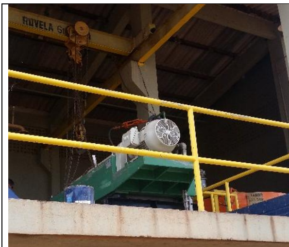
Foto 1 – Centrífuga em processo de instalação (RF/COFA/006/2015)
