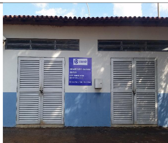
Foto 8 – Placa de advertência e identificação de unidade nova.
