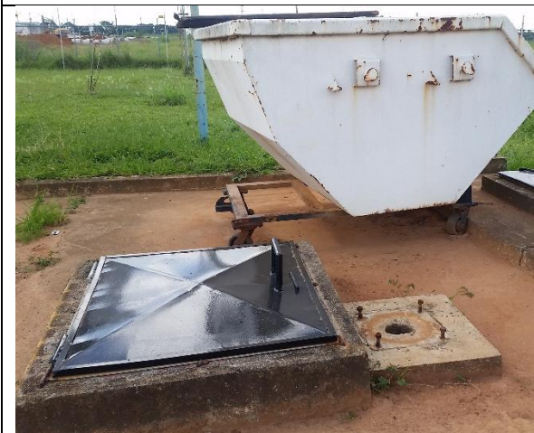
Foto 15 – Grade oxidada substituída por uma tampa nova (RF/COFA/006/2015).
