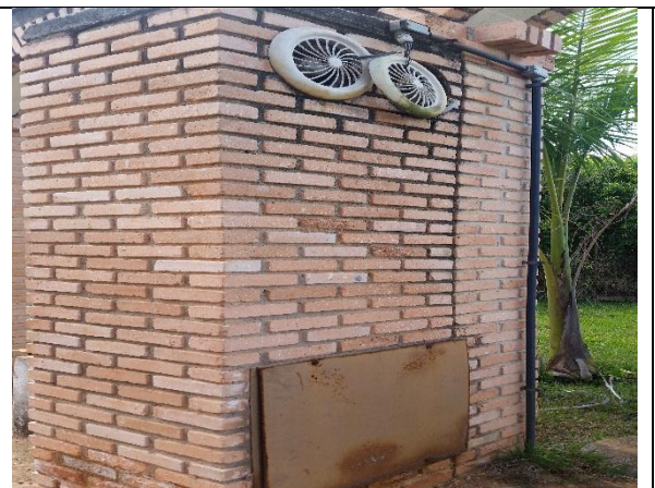
Foto 16 – Exaustores fora de operação (RF/COFA/003/2015)
