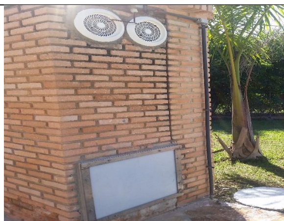
Foto 18 – Exaustores novos e em funcionamento.
