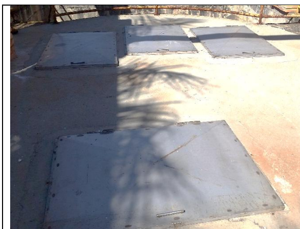
Foto 17 – Tampas novas do poço de sucção.
