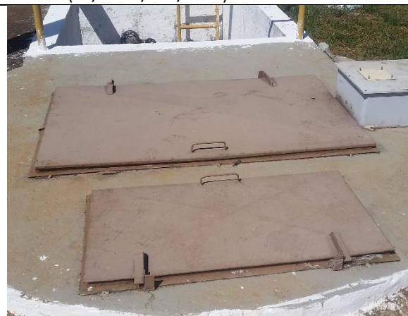
Foto 12 – Tampas recuperadas do poço de sucção.
