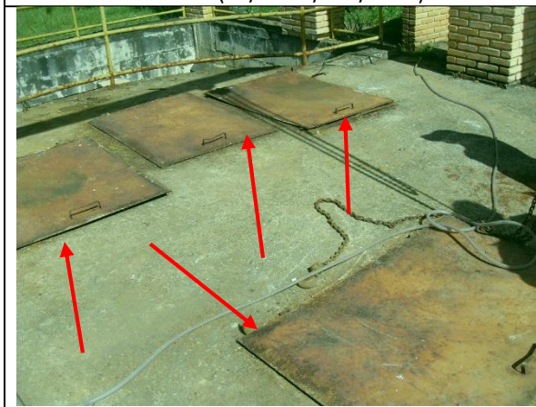
Foto 15 – Tampas do poço de sucção oxidadas (RF/COFA/003/2015)
