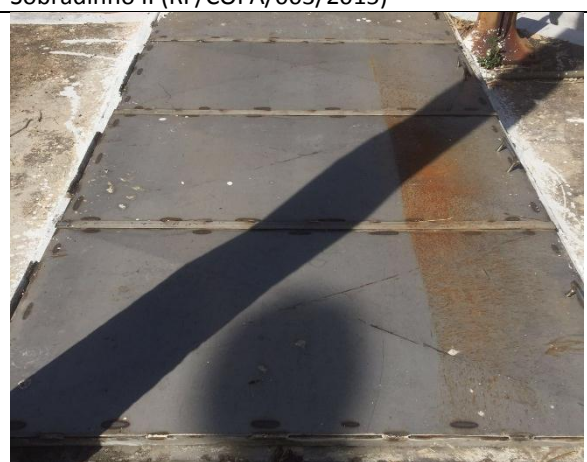
Foto 8 – Tampas novas do poço de sucção.
