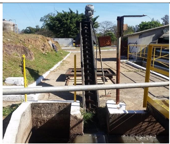
Foto 21 – Parafuso classificador inoperante.
