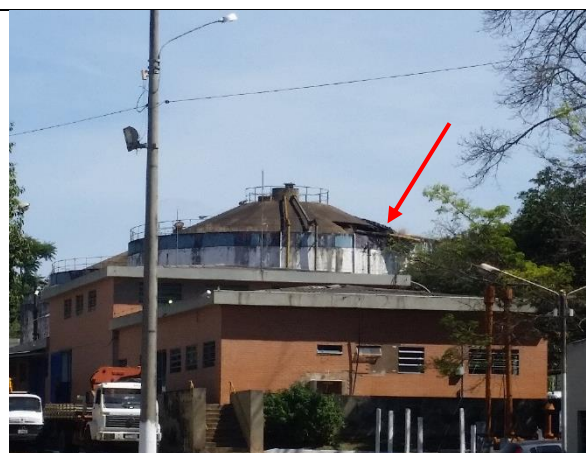
Foto 7 – Cúpula rompida do DGP 2.
