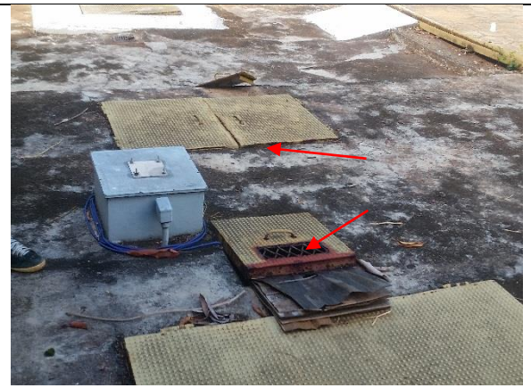
Foto 23 – Tampa corroída da EEB 08 Lago Sul.
