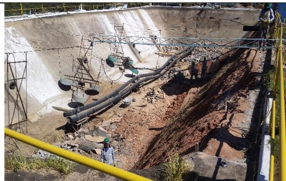
Foto 17 – Conserto do talude do Reator 1.
