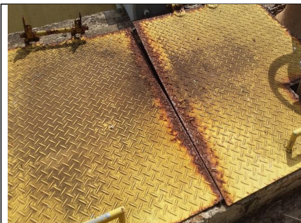
Foto 24 – Tampa em processo de oxidação na EEB Vila Planalto.
