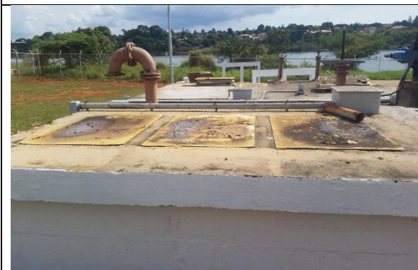
Foto 32 – Tampas oxidadas EEB 416 Norte
