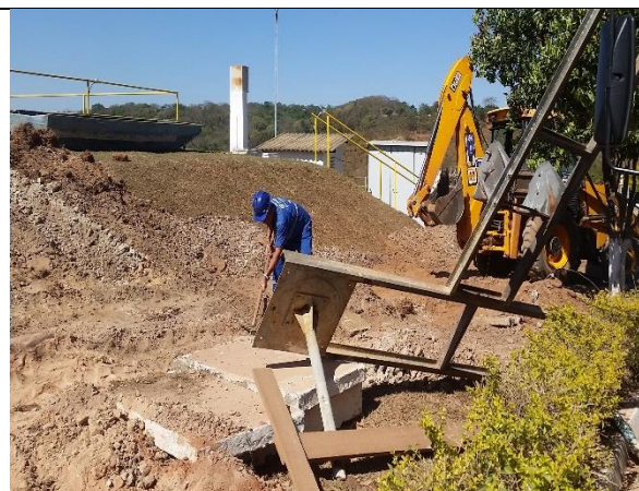
Foto 19 – Obra de substituição da tubulação.
