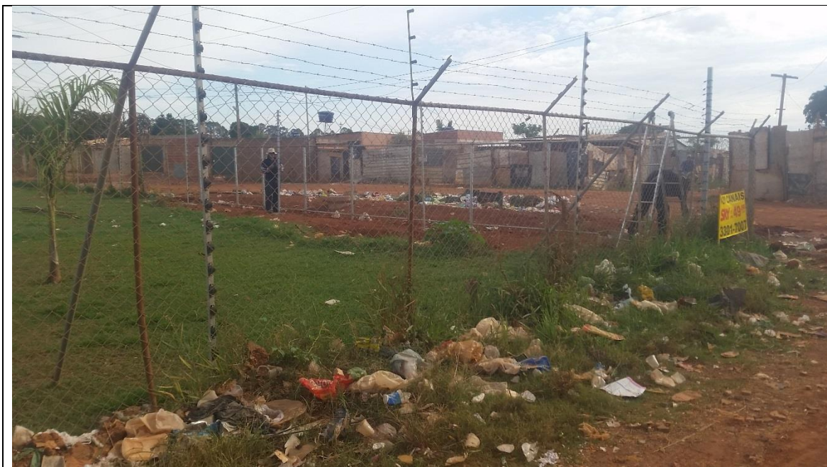
Foto 1 – Instalação da segunda cerca eletrificada e arredores da EEB Estrutural 2
