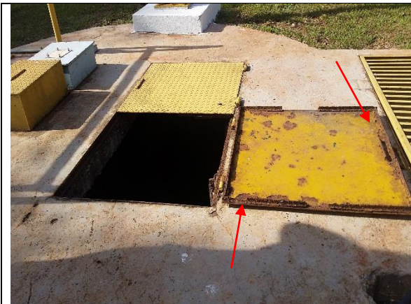
Foto 22 – Tampa corroída da EEB 06 Lago Sul.
