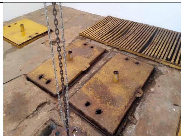
Foto 25 – tampas e grades corroídas na EEB Pier 21.
