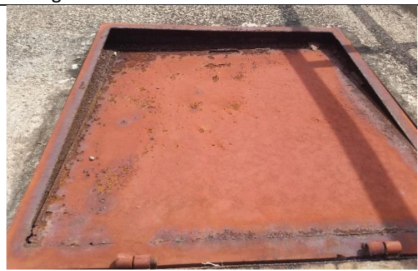
Foto 33 – Tampas oxidadas EEB 05 Lago Norte
