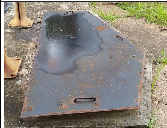
Foto 26 — Tampas em processo de oxidação EEB 413 Norte.
