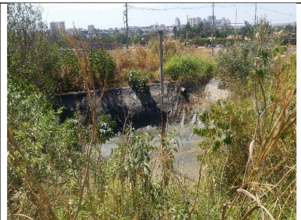
Foto 36 – Poço de segurança da EEB.AGC.004 em mau estado de conservação
