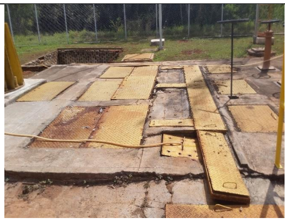
Foto 31 – Tampas com sinais de oxidação na EEB 04 Lago Norte.
