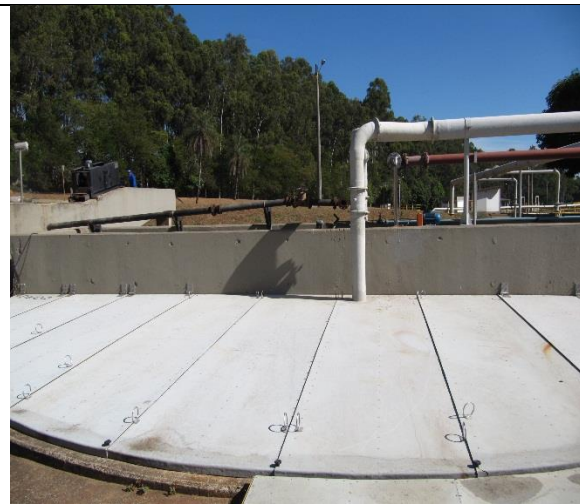
Foto 12 – Sistema de coleta de gases do tratamento preliminar
