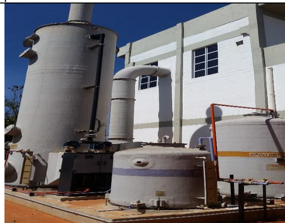
Foto 5 – Sistema de lavagem de gás da desidratação de lodo.
