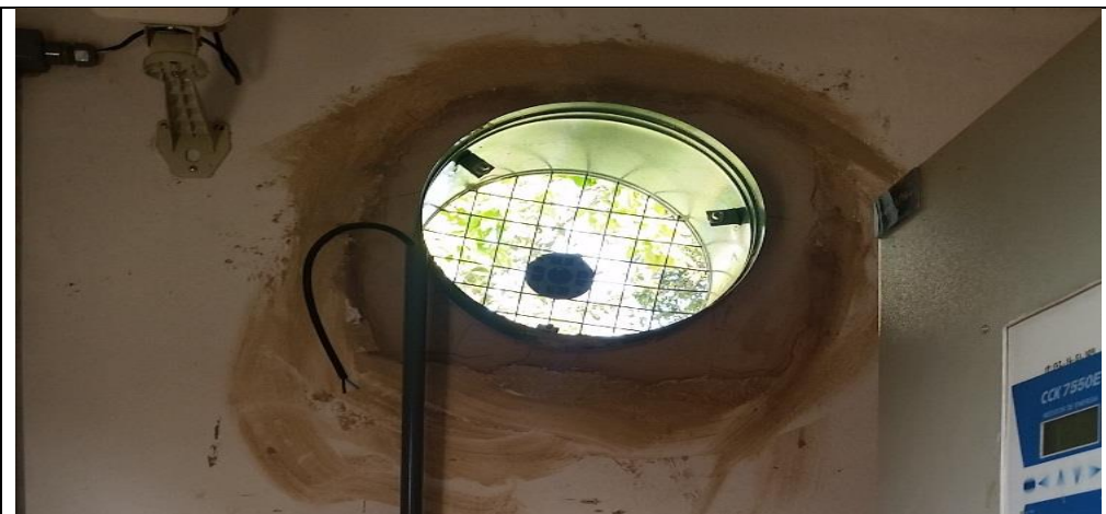
Foto 33 – Exaustor com instalação pendente na EEB 06 Lago Sul.
