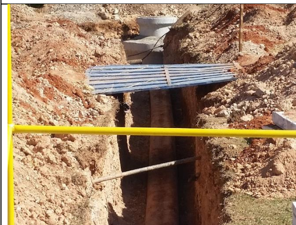
Foto 18 – Tubulação a ser substituída.
