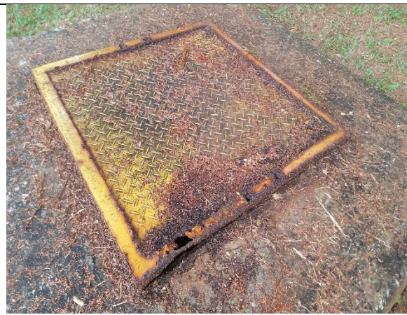
Foto 27 – Tampas oxidadas na EEB 01 Lago Norte.
