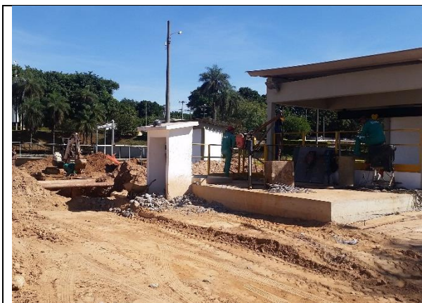
Foto 2 – Elevatória de lodo primário nova sendo reformada pela empresa contratada.
