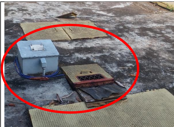
Foto 35 – Improviso no sensor de nível da EEB 008 Lago Sul
