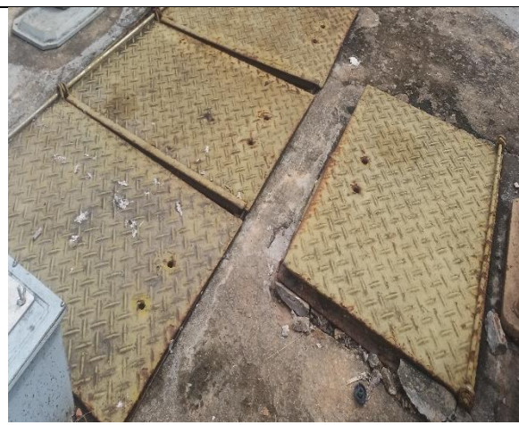
Foto 29 – Tampas oxidadas na EEB QE 46 Guara II.
