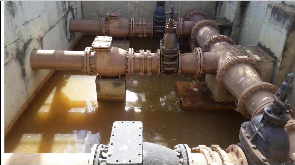
Foto 34 – Acúmulo de água na caixa do barrilete na EEB 04 Lago Sul.
