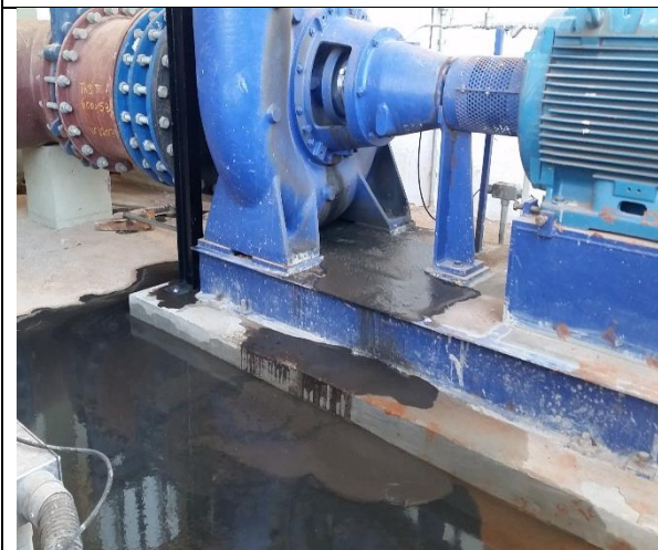
Foto 8 – Vazamento em uma das bombas de recirculação dos digestores novos.
