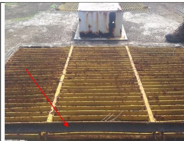
Foto 30 – Grade oxidada na EEB Metropolitana.
