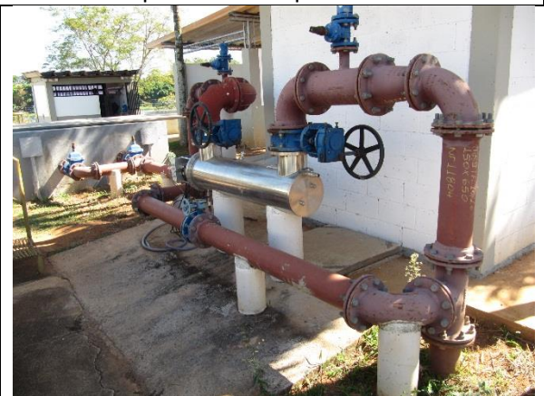
Foto 13 – Sistema de lavagem de gás do tratamento preliminar inoperante.
