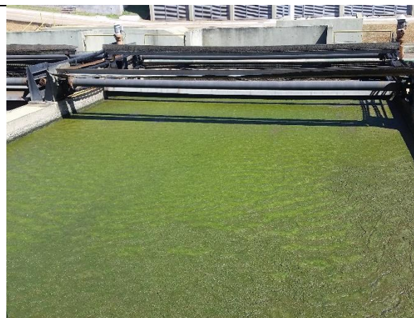
Foto 11 – Detalhe da câmara 3 do polimento final fora de operação.
