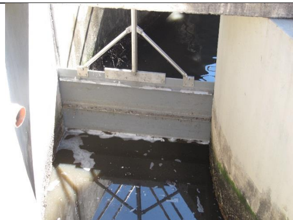
Foto 14 – Comporta não veda passagem de efluente.
