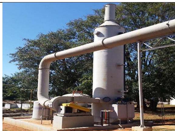
Foto 3 – Sistema de lavagem de gás do tratamento preliminar.
