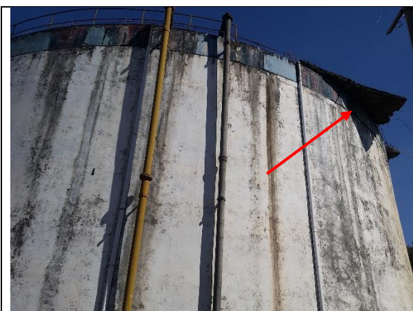
Foto 6 – Peça da cúpula quebrada do DGP 1.
