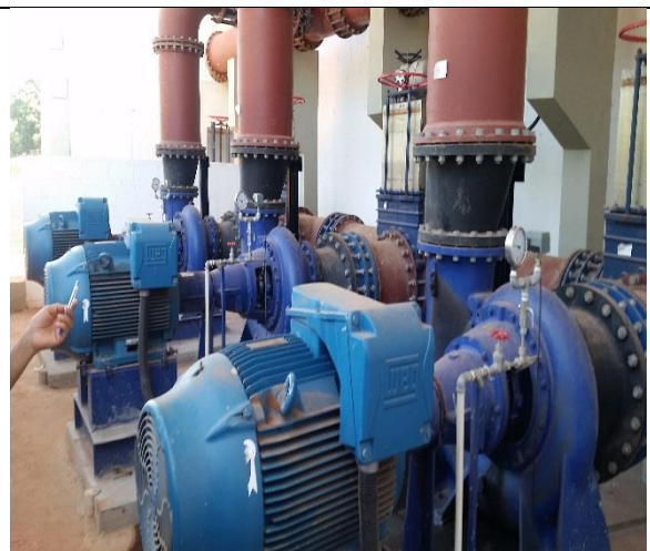
Foto 9 – Bombas de recirculação dos digestores novos.
