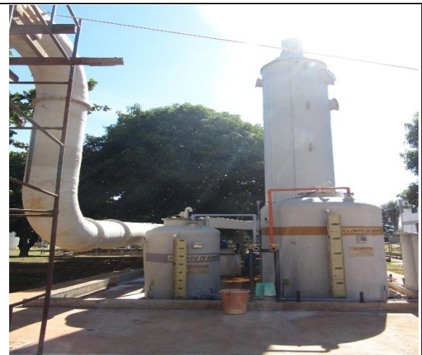
Foto 13 – Sistema de lavagem de gás do tratamento preliminar inoperante.
