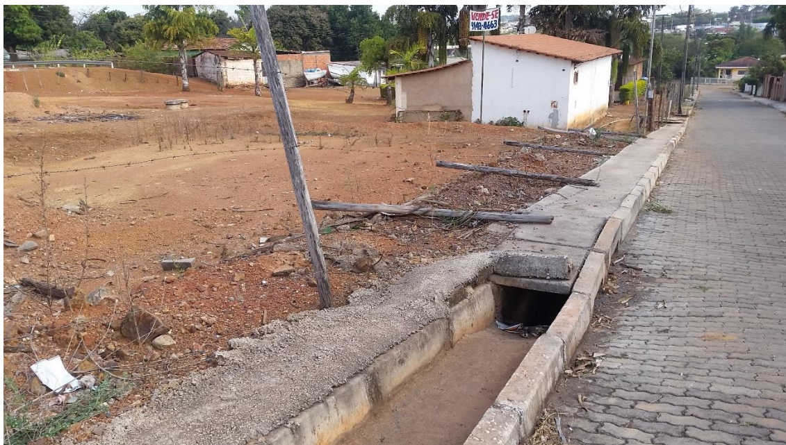
Foto 4 – Outros Poços de Visita (PVs) ao fundo e boca de lobo próxima ao local onde ocorreu o extravasamento sem sinais de novos vazamentos.
