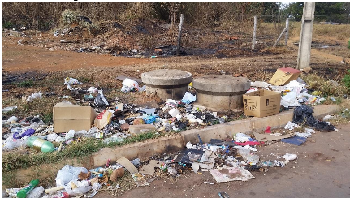
Foto 3 – Poços de Visita (PVs) próximos ao que extravasou sem sinais de novos vazamentos de esgoto.
