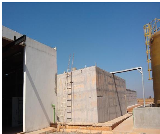
Foto 9 - Correção de vazamentos no tanque de contato.
