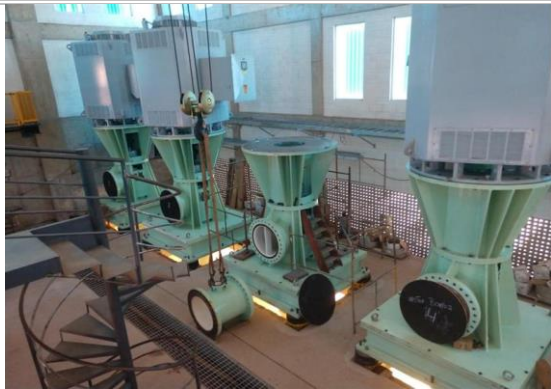
Foto 3 – Conjunto dos 4 motores (3+1 reserva)
