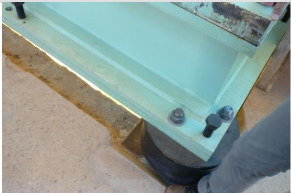
Foto 4 - Molas na estrutura da base do motor
