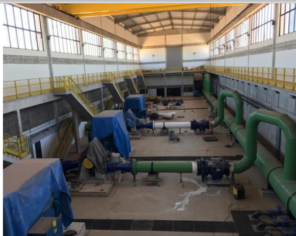
Foto 12 - Elevatória de Água Tratada
