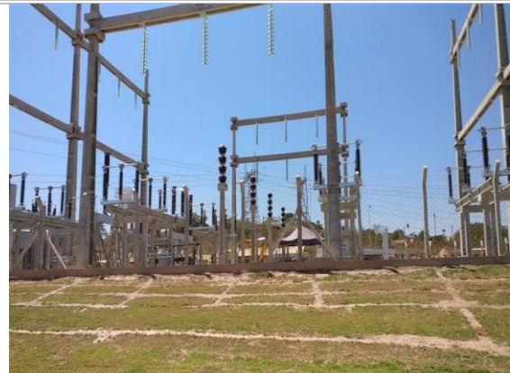
Foto 6 - Subestação aguardando chegada de energia.
