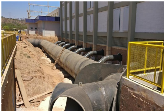
Foto 5 - Tubulações conectadas à adutora.
