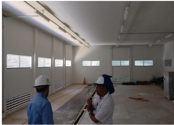
Foto 7 - Sala para instalação dos quadros de comando elétrico.
