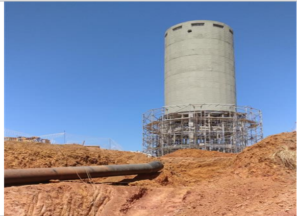
Foto 8 - Tanque de Amortecimento Unidirecional.
