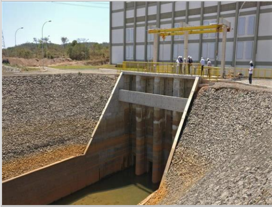
Foto 1 Ponto de instalação das comportas.
