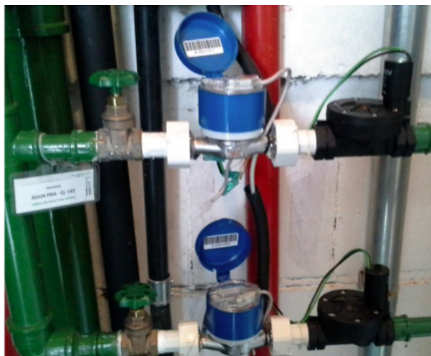
Foto 1. Sistema de telemetria com válvula de corte (Setor Habitacional Jardins Mangueiral) (Fonte: Caesb)
