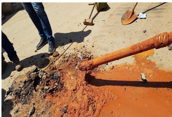
Foto 3 – Perfuração do solo para instalação de tubulação pelo método MND
