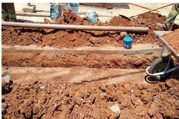
Foto 4 – Instalação de tubulação pelo método VAC
