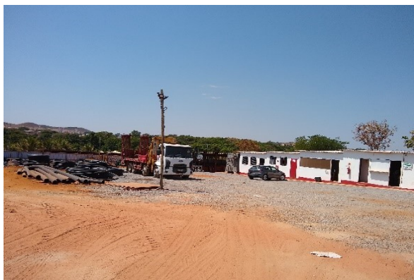
Foto 2 – Canteiro de obras de setorização em São Sebastião
