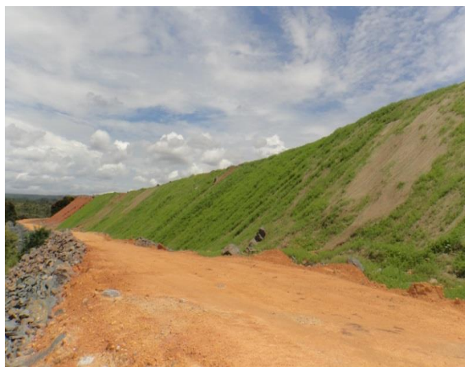
Figura 87 - Vegetação nos taludes com biomantas.
