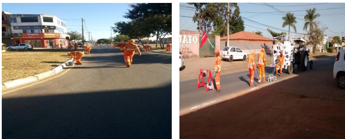
Figura 47 - Serviços de pintura de meio-fio.
