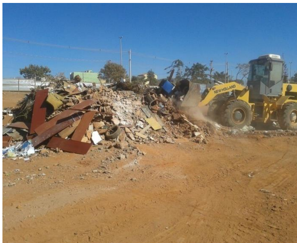
Figura 49- Recolhimento do entulho.
