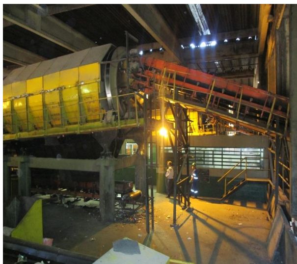
Figura 30 - Local de entrada dos resíduos e alimentação da peneira rotativa primária na UTMB.
