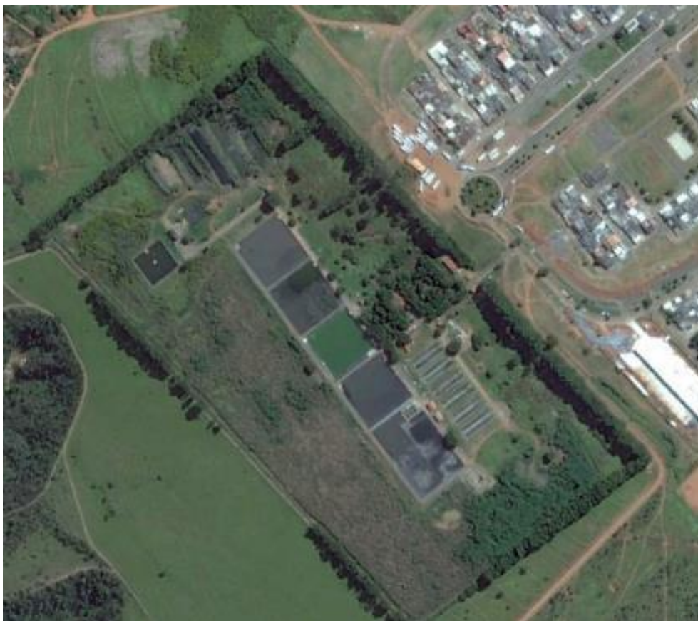
Figura 20: ETE Recanto das Emas/DF. (Fonte: Google Earth)
