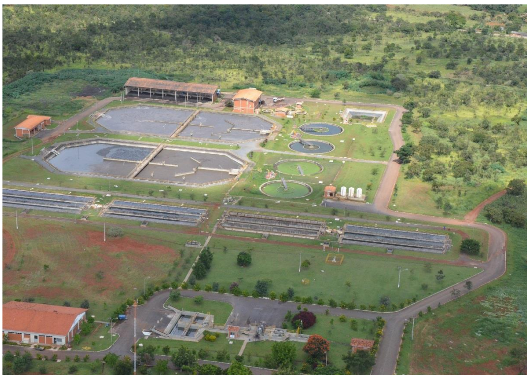
Figura 16: Estação de Tratamento de Esgotos Gama. (Fonte: Google Earth)
