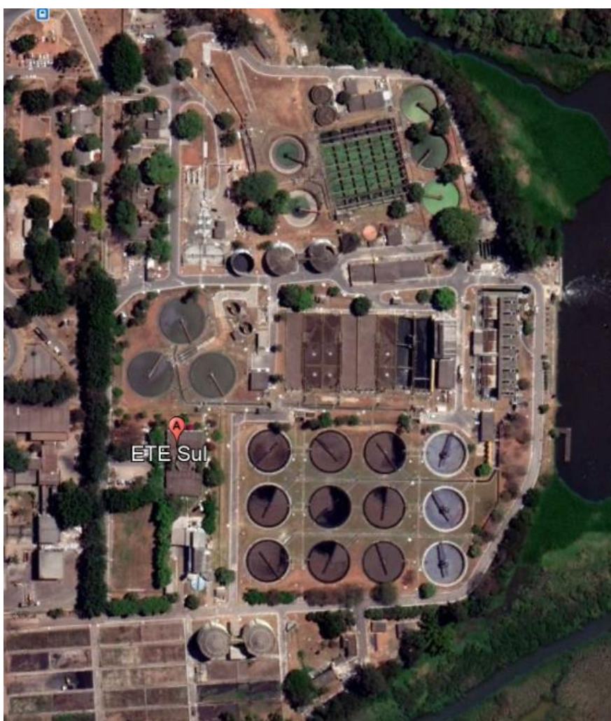
Figura 8: Estação de Tratamento de Esgotos Brasília Sul (ETEB Sul) (Fonte: Google Earth data: 2/2021)
