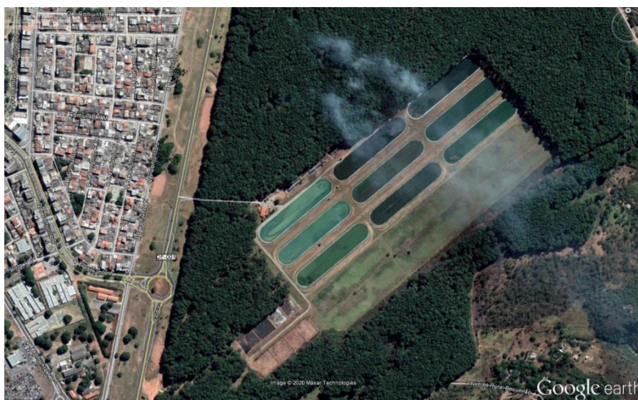
Figura 14: Localização da Estação de Tratamento de Paranoá, Paranoá – DF.
