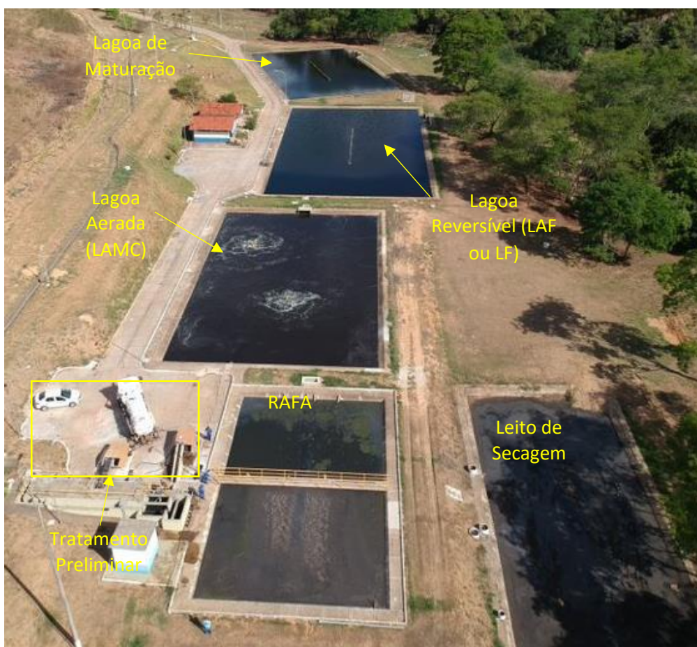
Figura 13: Vista aérea da Estação de Tratamento de Esgotos Vale do Amanhecer
