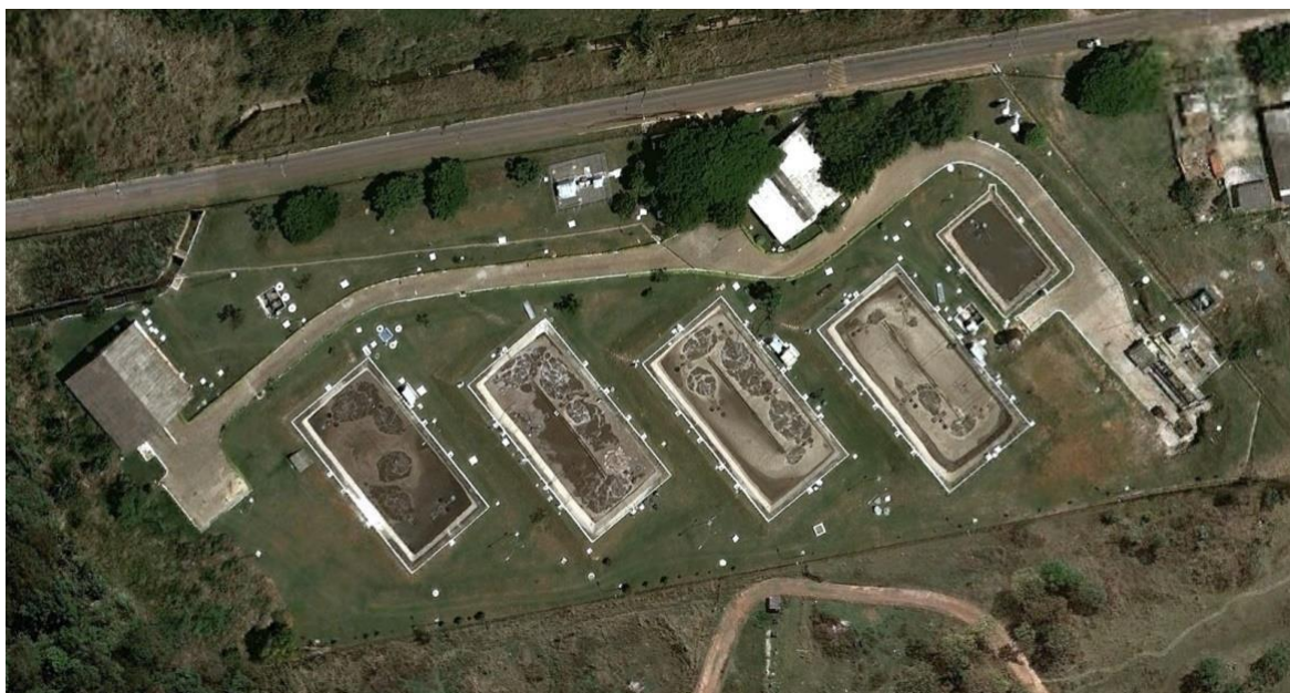
Figura 10: Vista aérea da ETE Riacho Fundo
