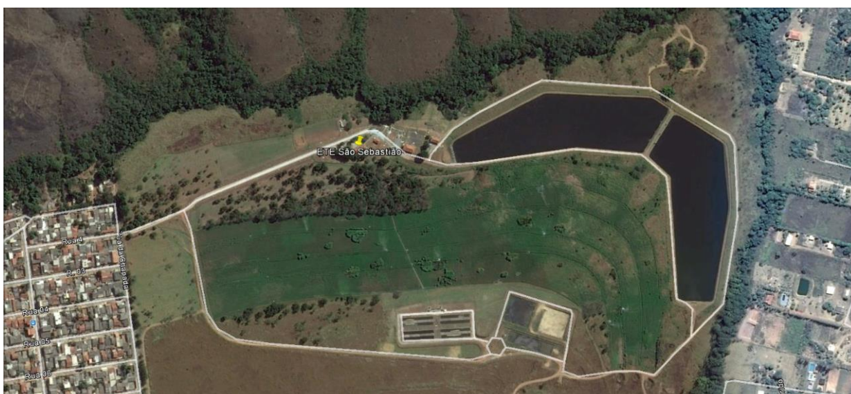
Figura 15: Estação de Tratamento de Esgotos -ETE São Sebastião. (Fonte: Google Earth)
