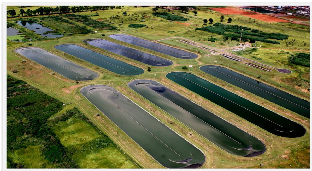
Figura 19: Detalhe da ETE Santa Maria. (Fonte: Caesb)
