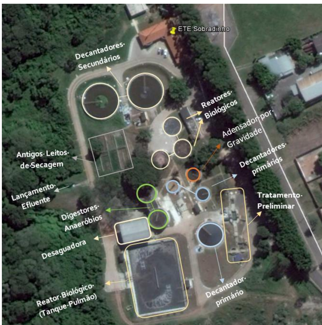
Figura 11: Estação de Tratamento de Esgotos Sobradinho
