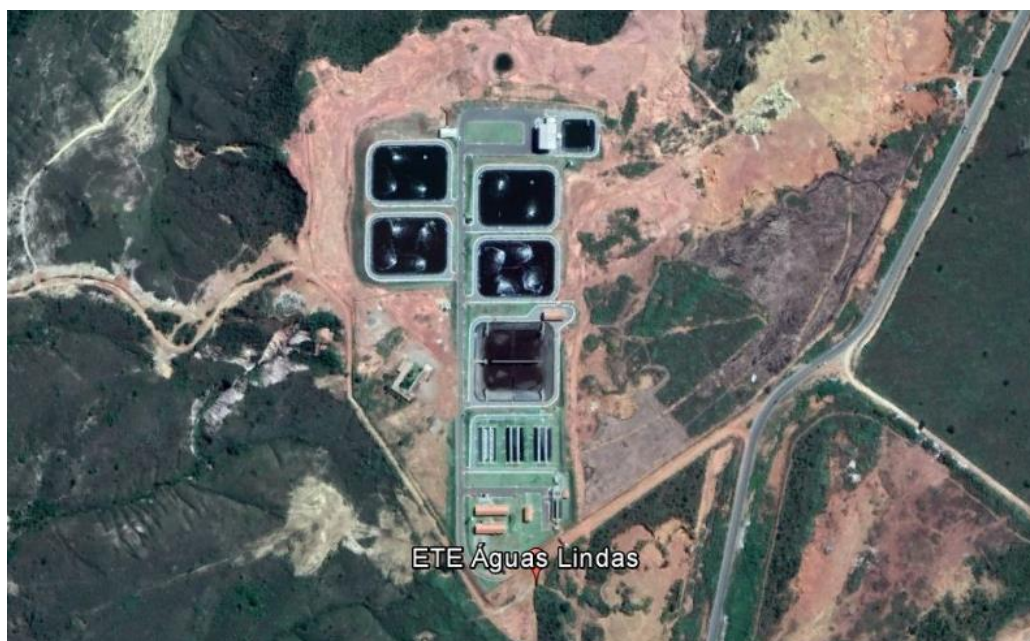
Figura 24: Detalhe da ETE Águas Lindas. (Fonte: Google Earth)
