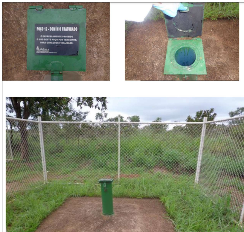
Figura 12.10 - Poço de monitoramento da Adasa. Fonte: Adasa (2023).
