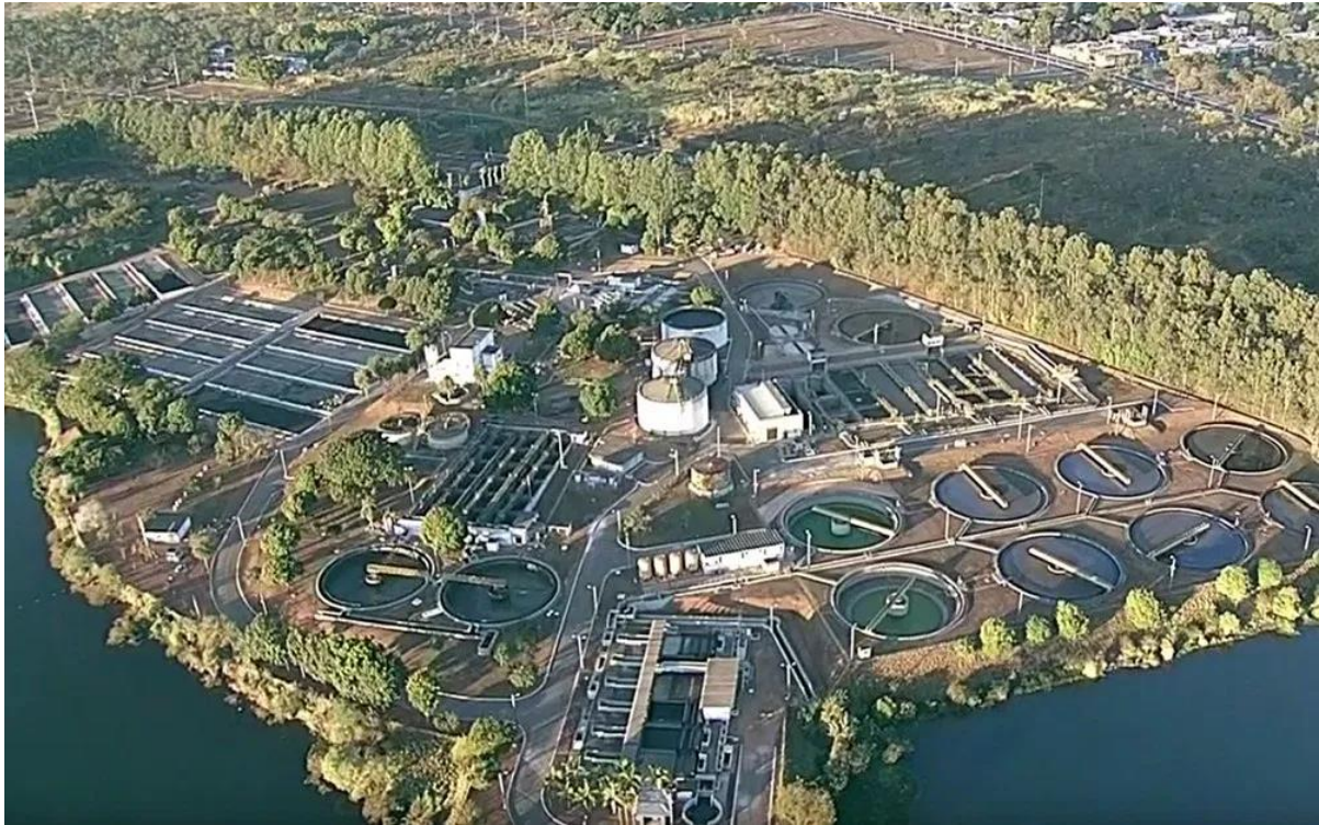
Figura 12.2-1: Estação de tratamento de efluentes: ETE Sul – Brasília
