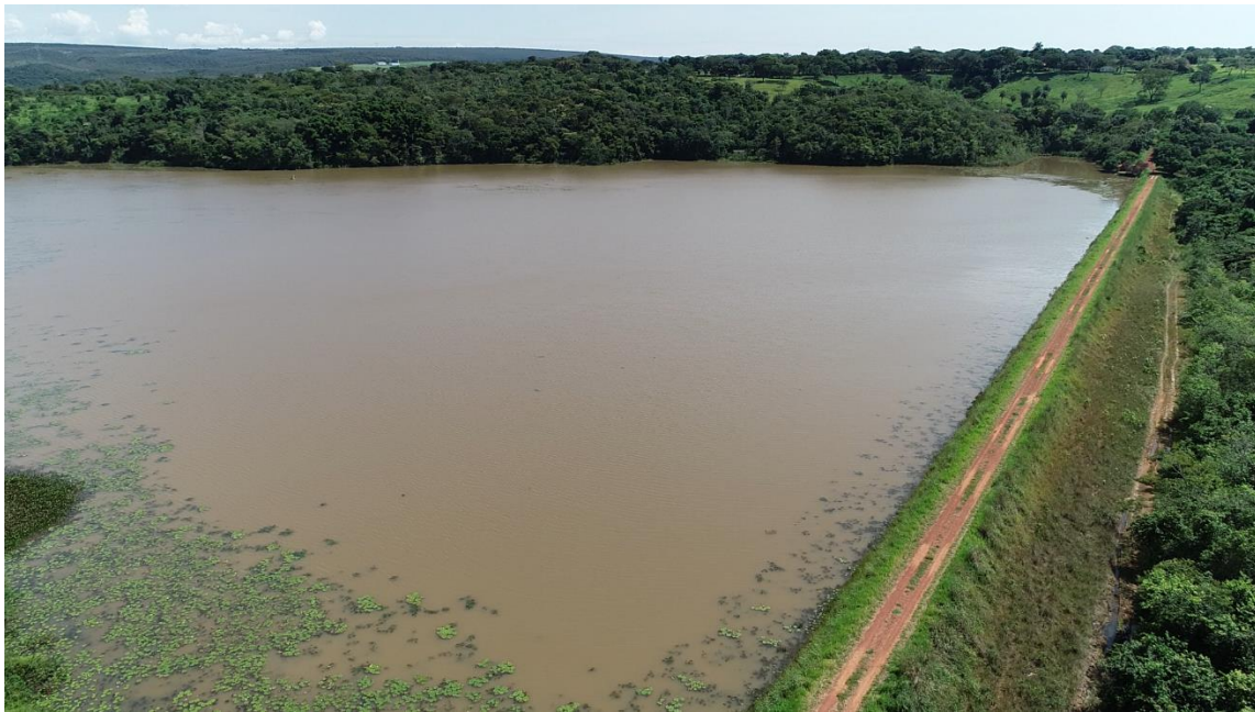
Figura 10-1: Barragem Vale Verde, Águas Lindas/GO
