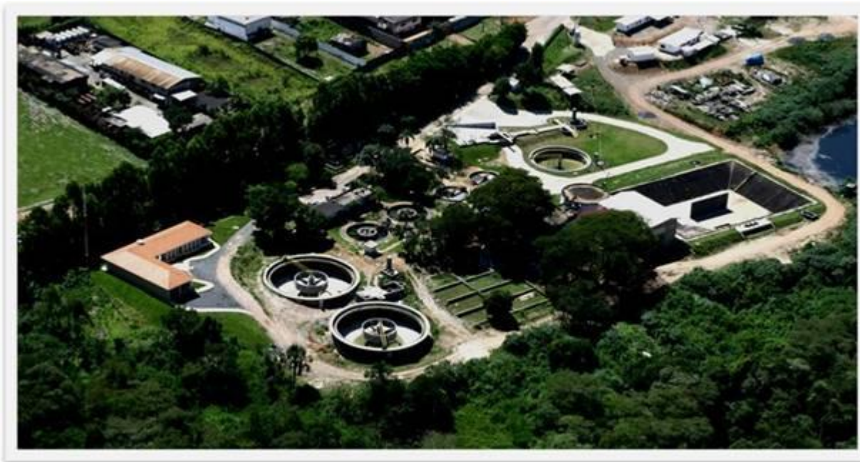
Figura 12.1-1: Estação de tratamento de efluentes: ETE Sobradinho – DF
