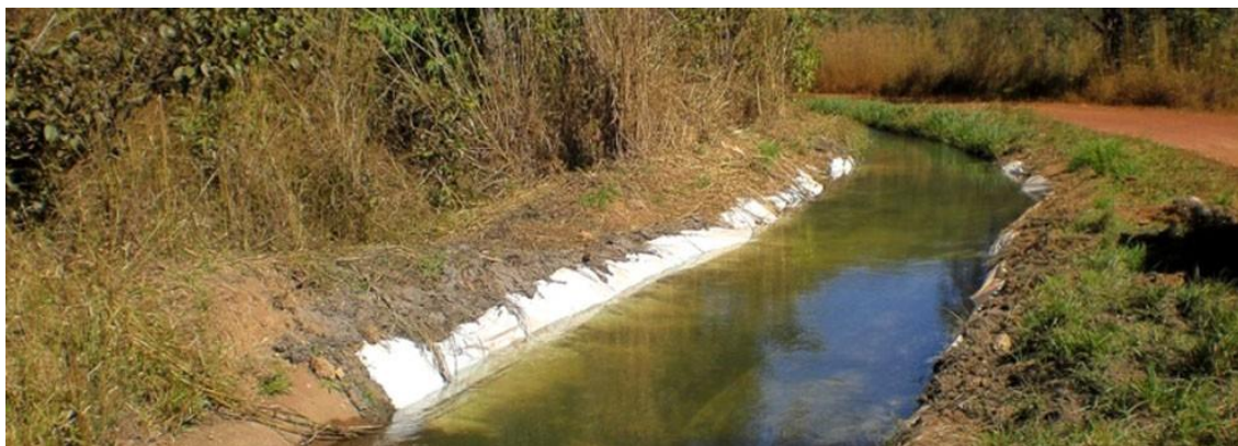
Figura 9.2-1: Canal de irrigação Santos Dumont antes das obras de tubulação
