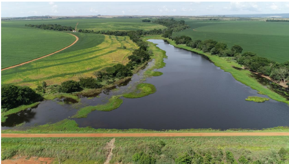
Figura 10.5-1: Barragem Cereal Citrus – vista jusante, Planaltina/DF
