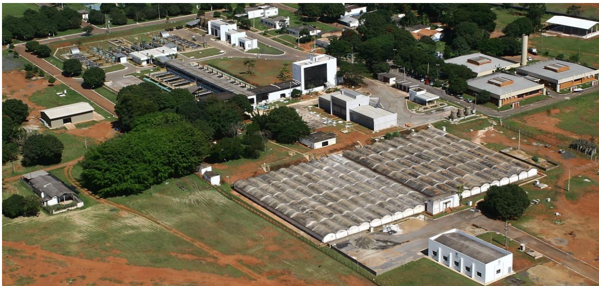
Figura 3.1-1: Estação de tratamento de água ETA Brasília.
