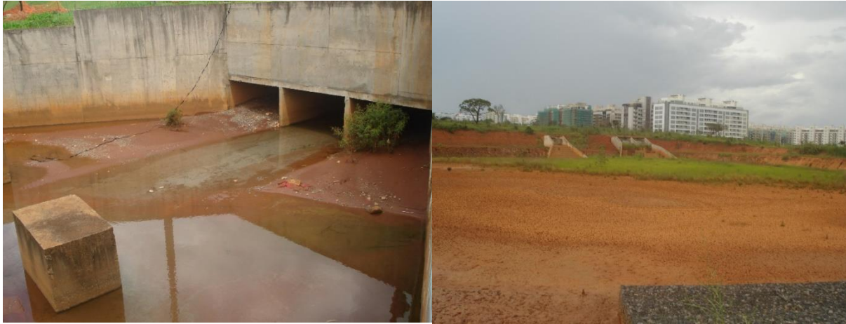
Figura 11-1: Galeria de águas pluviais e reservatório de retenção
