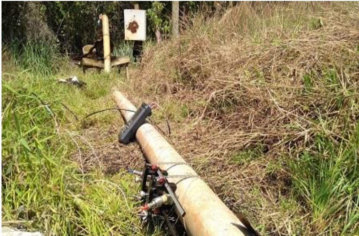
Figura 25. Medição de vazão em conduto fechado na bacia do Pipiripau
