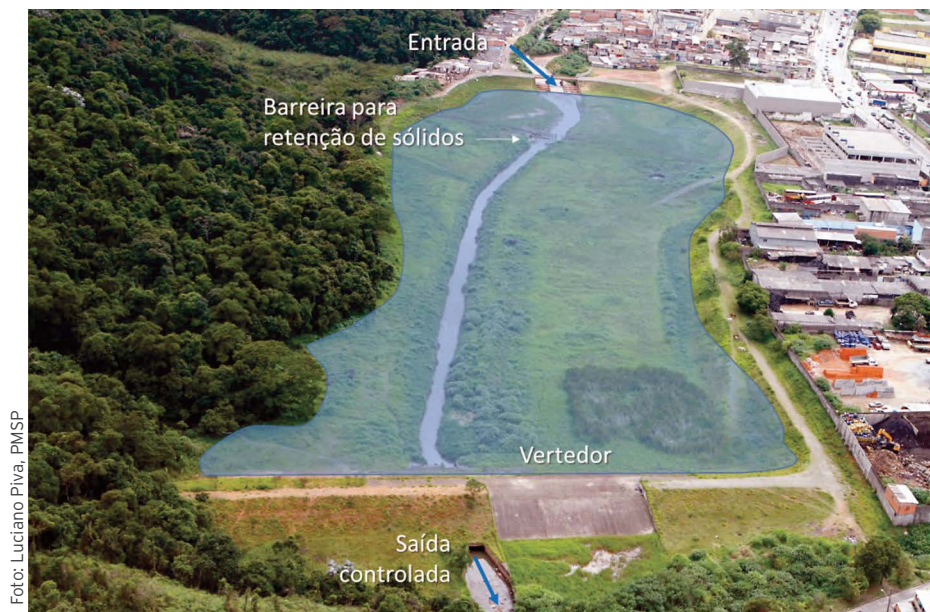
Figura 105 Reservatório in-line , Aricanduva 2, em São Paulo.
