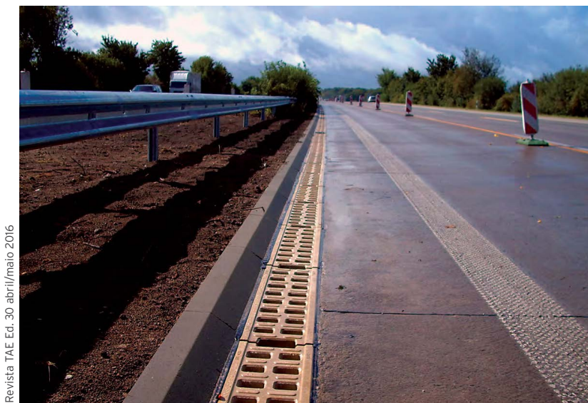
Figura 21 Captações Lineares de Águas Pluviais.
