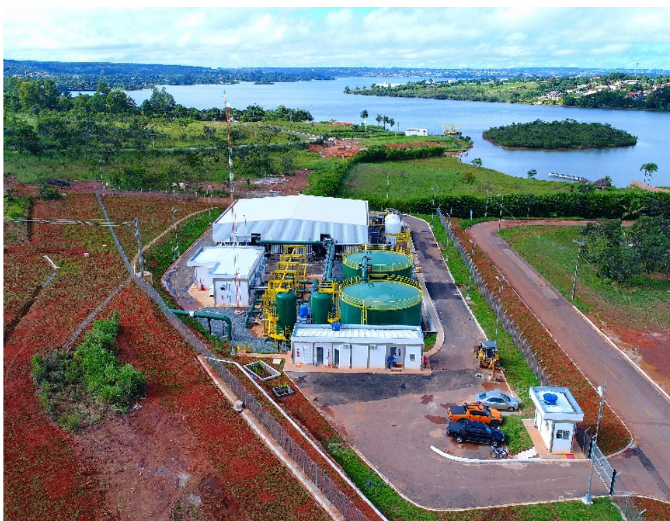
Figura 1. Área de implantação da Estação de Tratamento de Água (ETA) emergencial no Lago Norte
