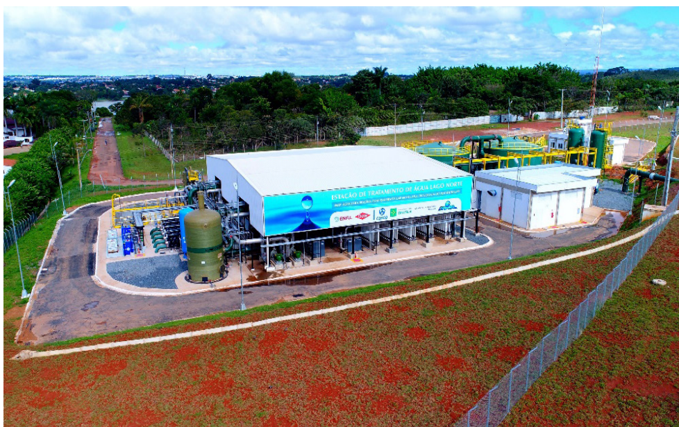
Figura 3. Estação de Tratamento de Água (ETA) emergencial no Lago Norte, que utiliza a tecnologia de membranas de ultrafiltração
