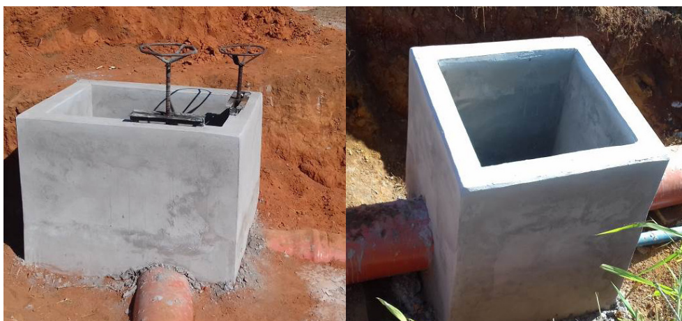
Figura 5. Caixas de distribuição e derivação em canal tubulado
