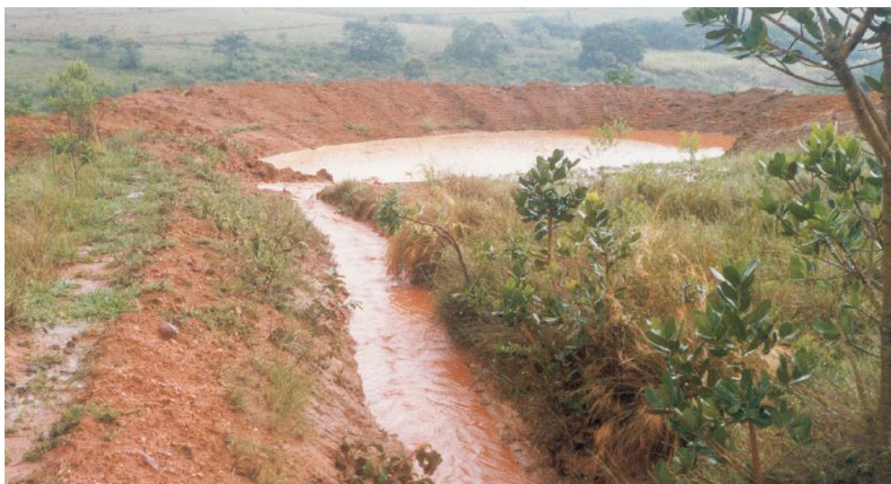
Figura 4. Bacia de contenção represando a água da enxurrada
