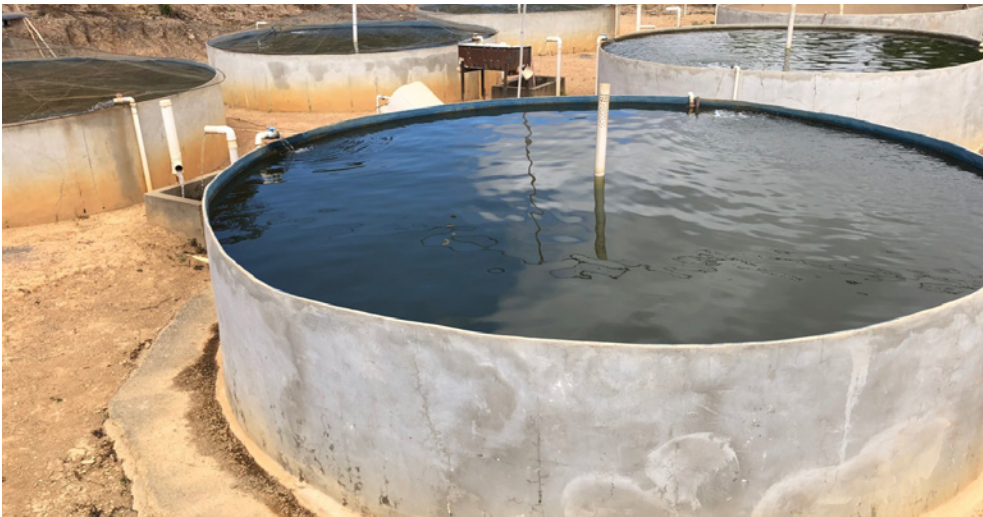
Figura 6. Produção de peixes em tanques circulares de ferro-cimento
