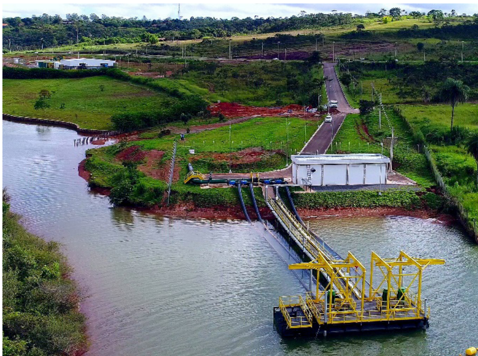
Figura 2. Área de implantação da captação flutuante no Lago Paranoá. Ao fundo observa-se a Estação de Tratamento de Água (ETA) emergencial no Lago Norte
