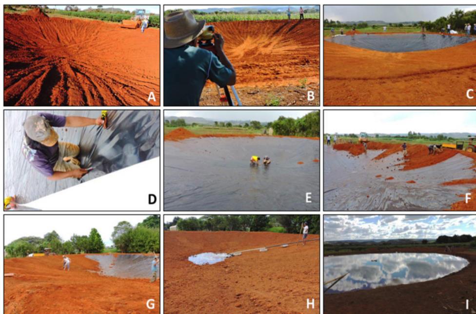
Figura 2. Esquema passo a passo da abertura e revestimento dos reservatórios. A: Abertura dos reservatórios. B: Nivelamento das bordas. C: Instalação da lona plástica. D: Colagem das emendas. E: Reservatório totalmente revestido. F: Início da cobertura da lona com terra. G: Distribuição da terra sobre a lona plástica. H: Início do enchimento do tanque com água. I: Tanque concluído reservando água
