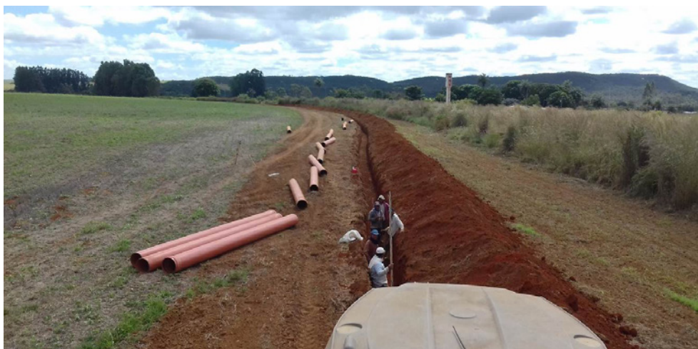
Figura 4. Revestimento de canal de irrigação do Lamarão com tubos de PVC
