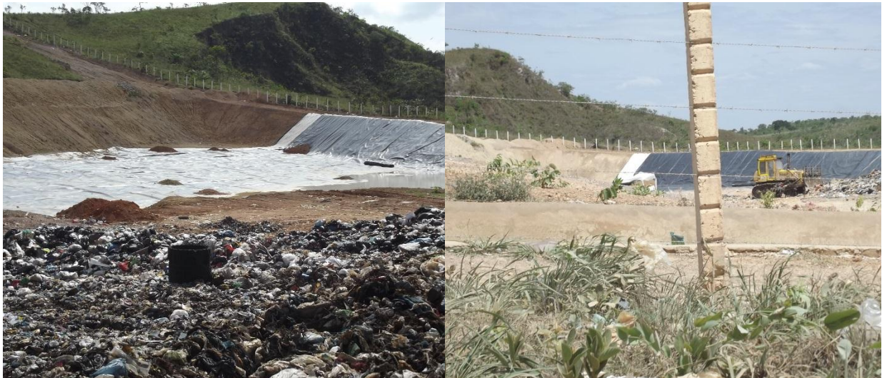
Figura 7 - Aterro Sanitário Planaltina de Goiás.
