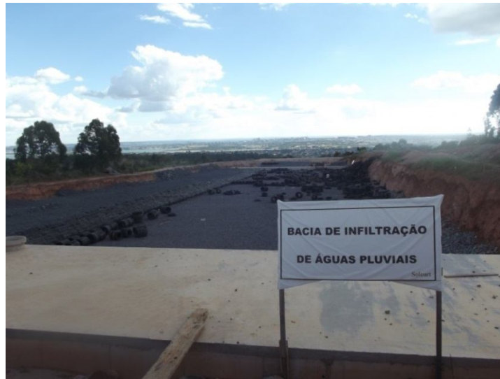
Figura 15 - Bacia de detenção Torre Digital
