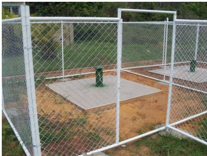
Figura 25. Poços da rede de monitoramento das águas subterrâneas
