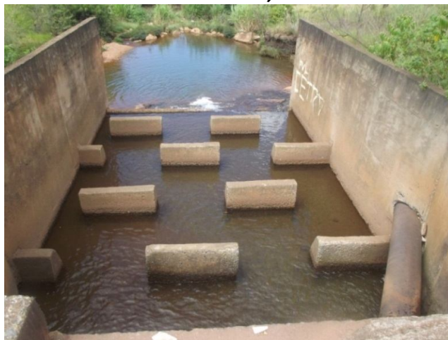
Figura 16 - Estrutura de saída de bacia de detenção de águas pluviais (Bacia DF-290: Santa Maria - NOVACAP)
