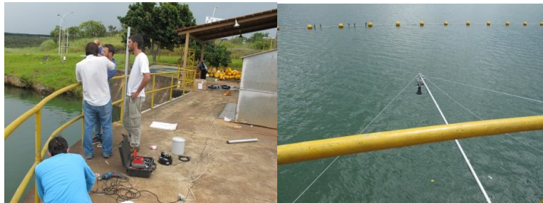
Figura 31. Instalação da estação telemétrica do Lago Paranoá
