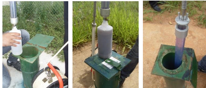
Figura 21: Poços de coleta de água da rede subterrânea, DF – 2013.
