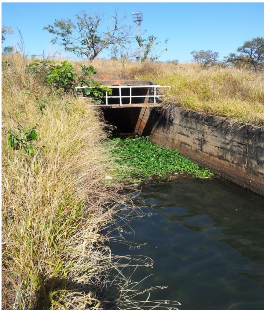
Figura 17 - Lançamento de águas pluviais no Lago Paranoá – Centro Olímpico da Universidade de Brasília – UnB.
