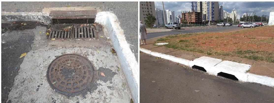
Figura 14 - Componentes da microdrenagem no DF.
