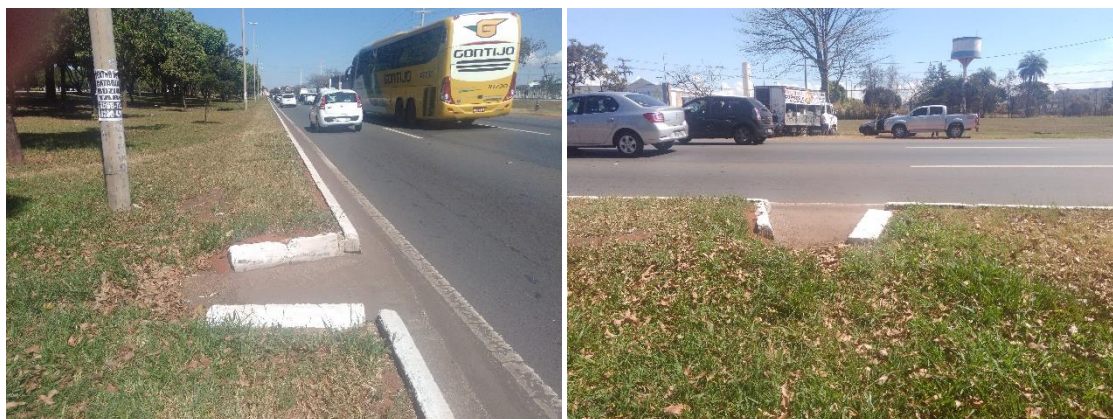
Figura 15 - Microdrenagem rodoviária (EPIA - DF 003).
