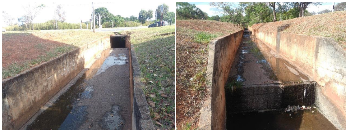
Figura 16 - Canais de drenagem do Parque da Cidade.
