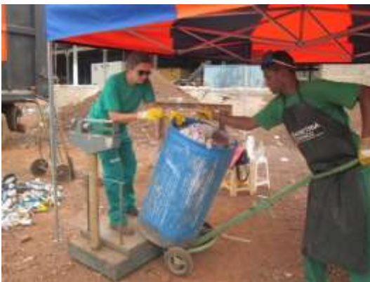
Figura 20 - Pesagem da amostra e despejo na mesa de triagem.
