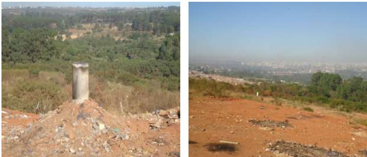
Figura 51 - Dreno de gás do maciço e área encerrada com cobertura de terra.
