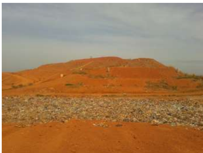
Figura 74 - Área frontal do Aterro Sanitário em junho de 2016 Fonte: SERENCO.
