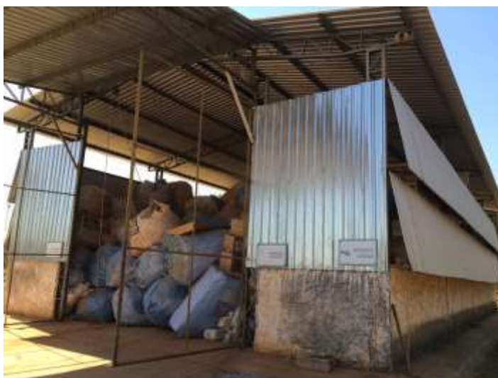
Figura 107 - Galpão do posto de recebimento PAD/DF.
