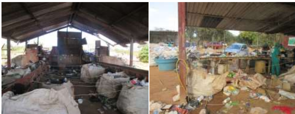
Figura 51 - Infraestrutura interna ACOBRAZ.
