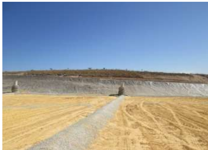
Figura 64 - Área de depósito do Aterro de Padre Bernardo - GO. Fonte: SERENCO.
