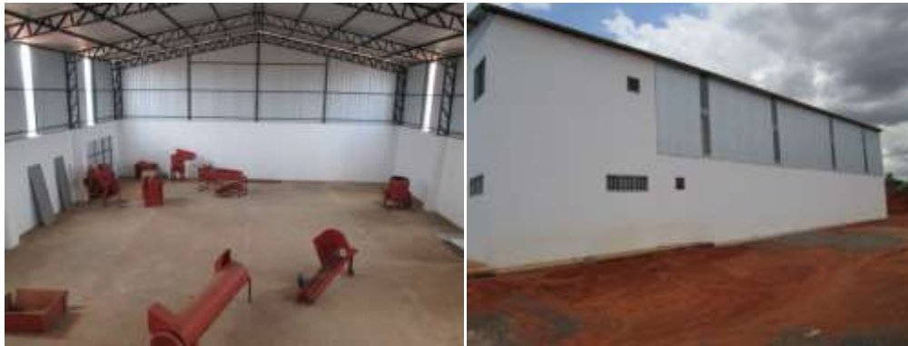
Figura 60 - Galpão da cooperativa COOPERCOCO.
