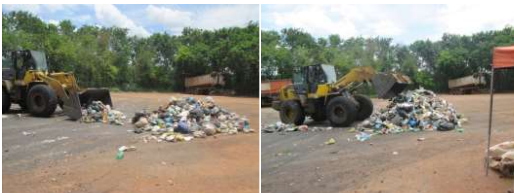
Figura 93 - Mistura e homogeneização de duas partes opostas restantes.
