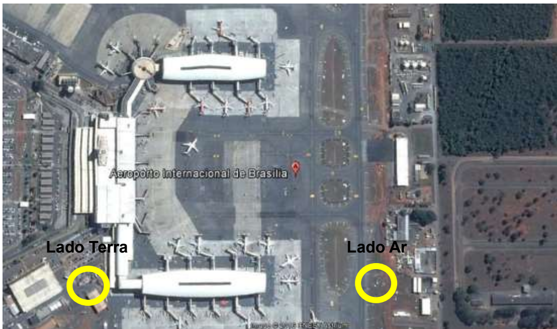
Figura 92 - Centrais de armazenamento de resíduos.
