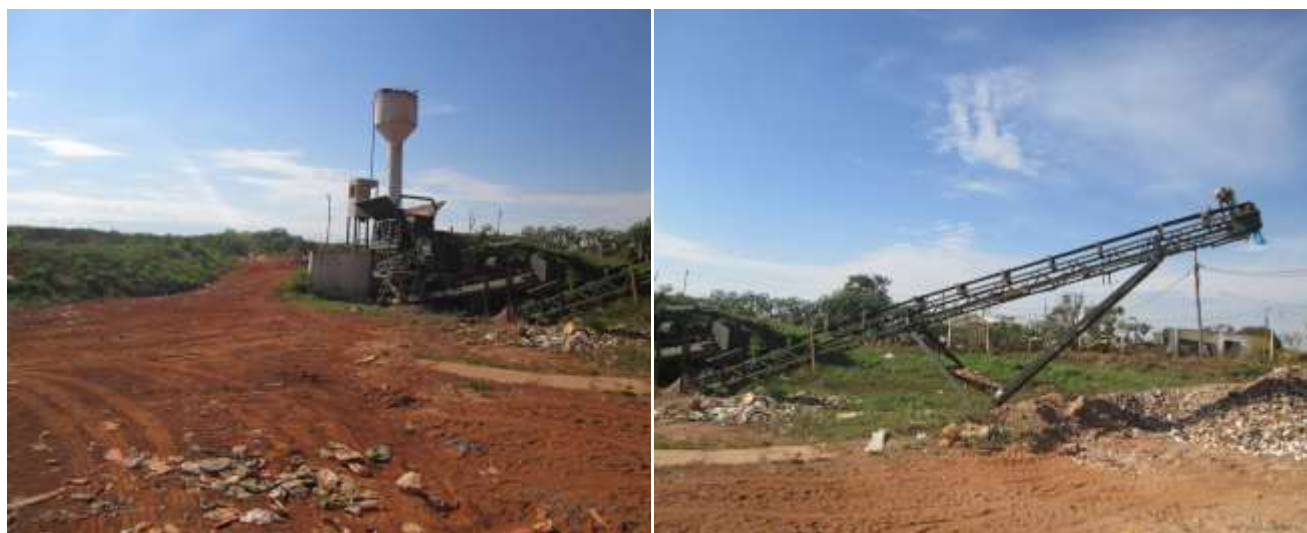
Figura 69- Britador de RCC dentro do Aterro do Jóquei.
