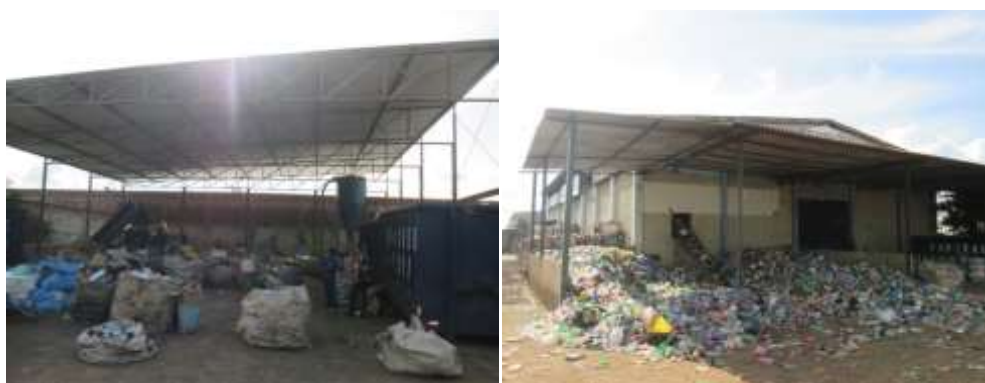
Figura 40 - Estrutura externa dos galpões RECICLE A VIDA. Fonte: SERENCO.
