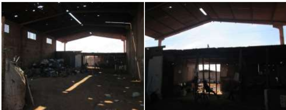
Figura 47 - Infraestrutura interna do galpão.
