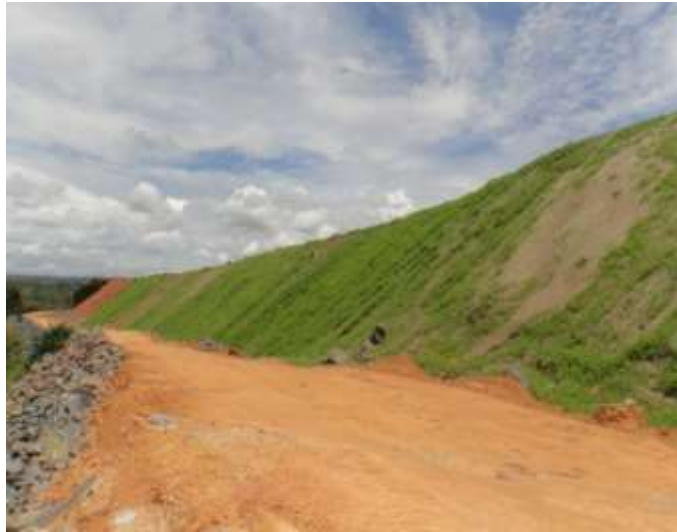
Figura 101 - Vegetação nos taludes com biomantas.
