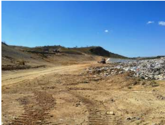
Figura 69 - Área de depósito de RSU em junho de 2016. Fonte: SERENCO.
