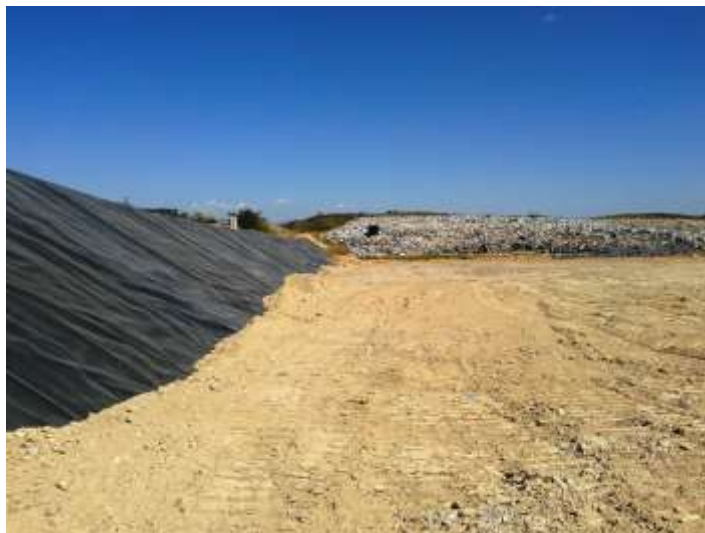
Figura 70 - Vista lateral da impermeabilização do Aterro Sanitário. Fonte: SERENCO.
