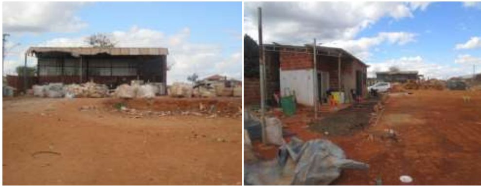
Figura 52 - Estrutura externa R3. Fonte: SERENCO.
