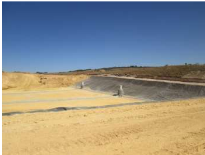
Figura 66 - Área de depósito finalizada - 10.000 m². Fonte: SERENCO.
