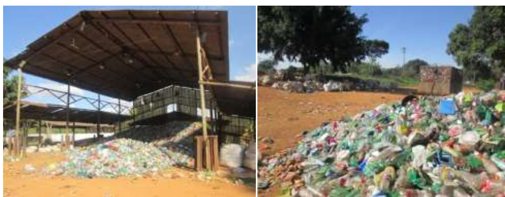
Figura 5 - Estrutura externa e local de triagem.
