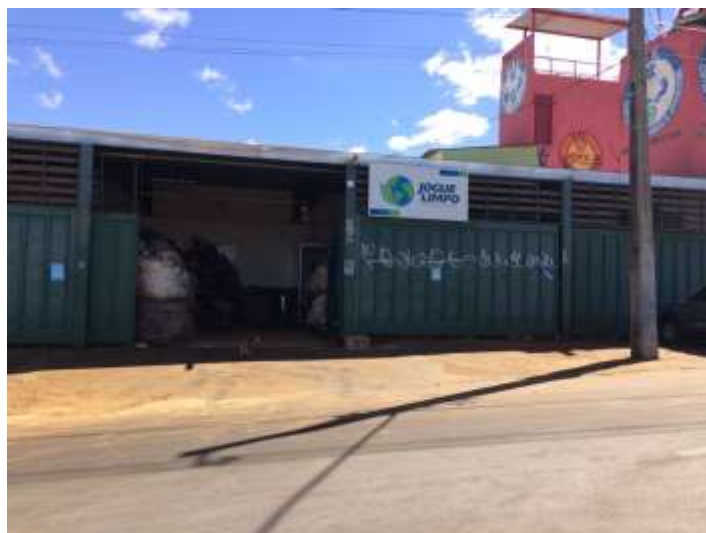
Figura 126 - Vista da central de recebimento de embalagens de óleos lubrificantes Fonte: SERENCO.
