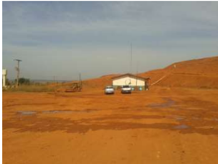
Figura 73 - Área administrativa e operacional do Aterro Sanitário. Fonte: SERENCO.
