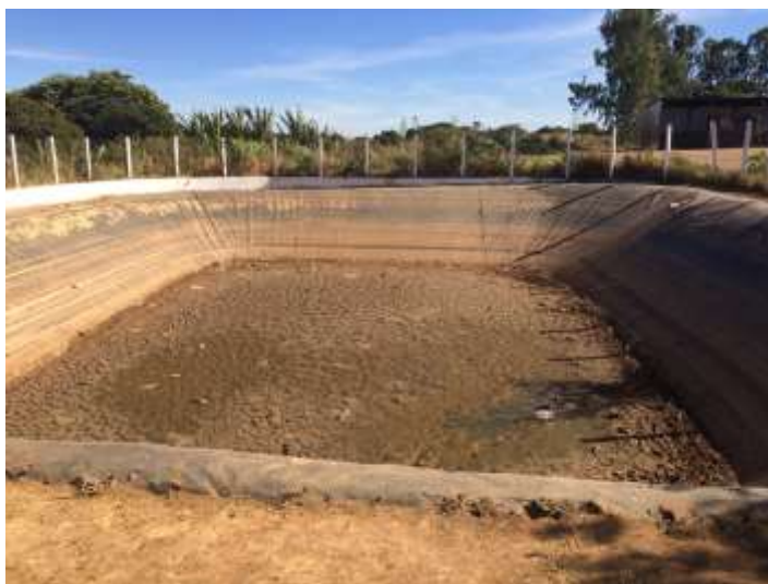
Figura 39 - Lagoa de estabilização com revestimento em PEAD.
