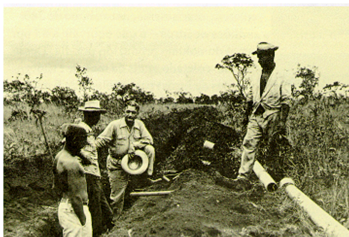
Figura 5 – Primeiras canalizações de água em Brasília
